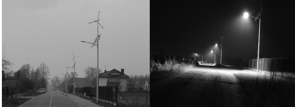
Rys. 2. Widok dzienny oraz nocny poprawnie działającego hybrydowego systemu oświetlenia [7]
