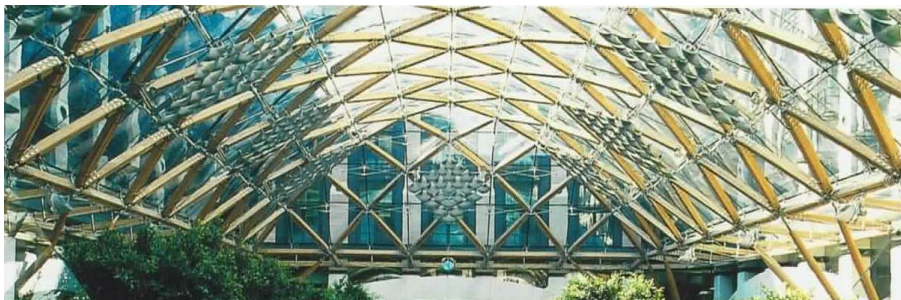
Rys. 2. Konstrukcja przekrycia atrium Portcullis House w Westminsterze [15]
