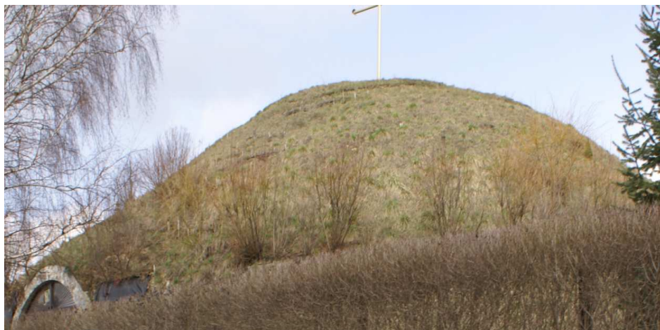
Fot. 5. Fragment kopuły kurhanu przykryty warstwą iltu glinianego i ziemi urodzajnej, obsiany trawą oraz niskimi krzewami. Widok od strony wejścia do budowli.
