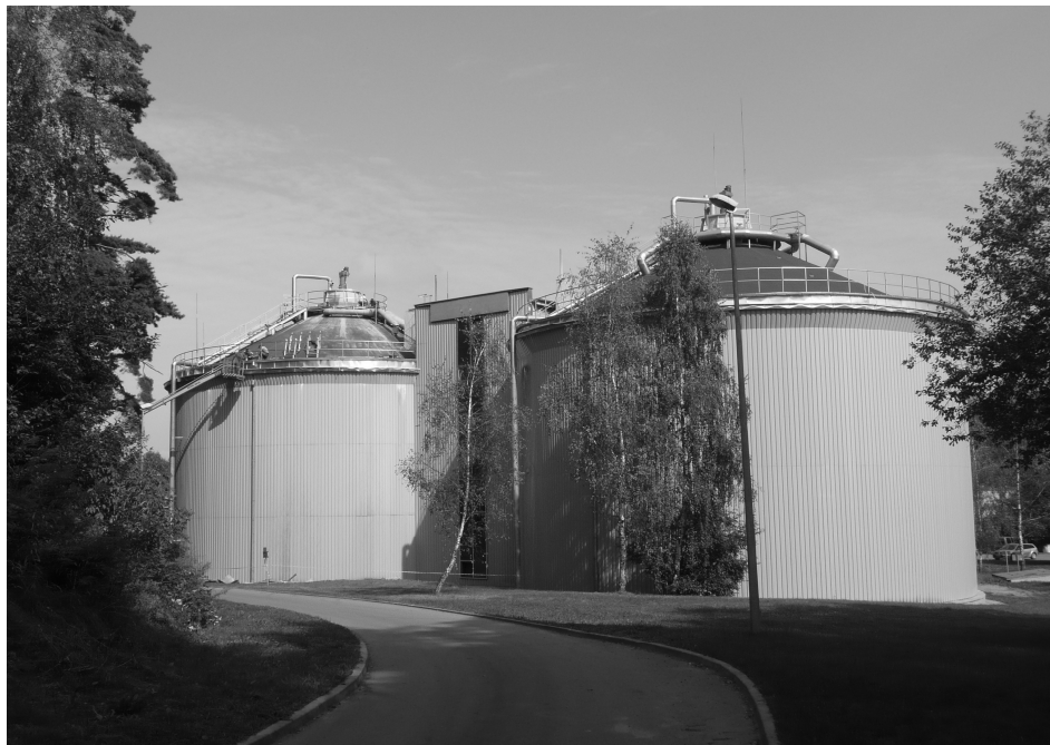
Rys.1. Zamknięte komory fermentacyjne (ZKF)
