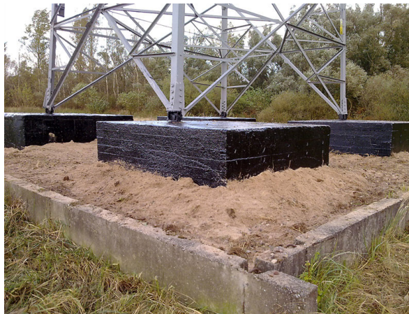
Rys. 3. Przykład fundamentu słupa energetycznego wysokiego napięcia 110 kV
