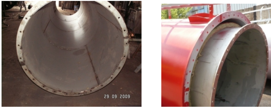
Rys. 1. Widok segmentu przewodu spalinowego trakcie wykonawstwa i podczas montażu
