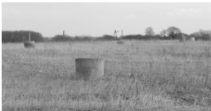
Rys. 3. Studnie odgazujące na SOK w Jarosławiu (fot. własna)
