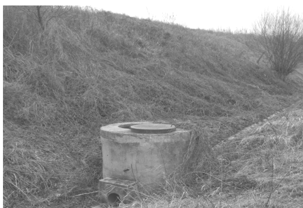
Rys. 2. Betonowa studnia zbiorcza na SOK odbierająca wody spływowe z dwóch rowów opaskowych (fot. własna)
