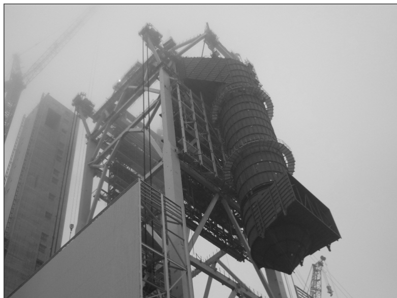
Rys. 17. Podnoszenie konstrukcji wiszącej (HBH) budynku kotłowni.
