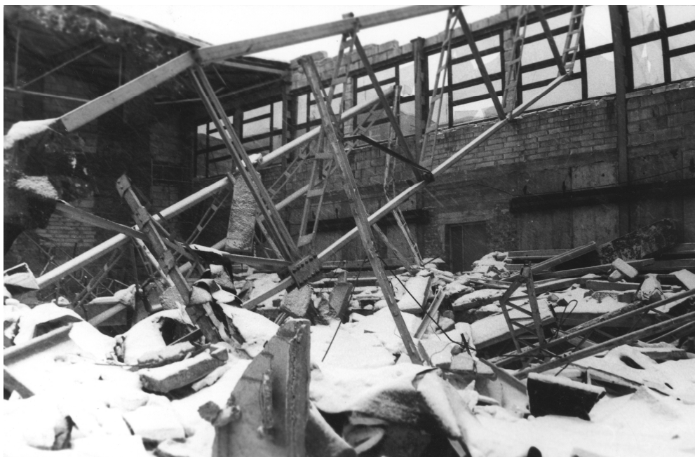
Rys. 10. Zniszczone pokrycie dachowe sali gimnastycznej z rysunku 9
