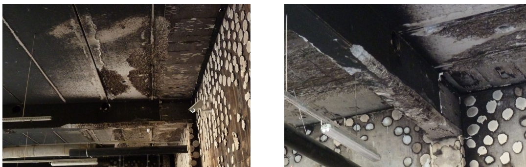
Rys. 7. Wygląd elementów, w których wystąpiło odpryskiwanie termiczne betonu (fot. autora)
