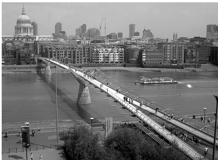
Rys.4. Kładka Milenijna w Londynie, zamknięta w następnym dniu po otwarciu z powodu nadmiernych drgań
