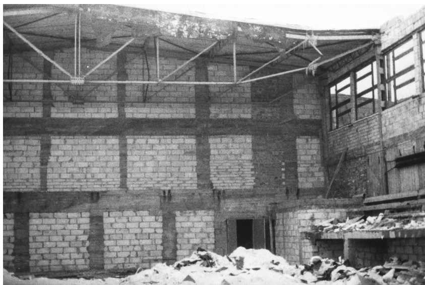
Rys. 9. Wiażar dachowy zniszczonej sali gimnastycznej, który połączony był ze ścianą szczytową tężnikiem międzywiązarowym
