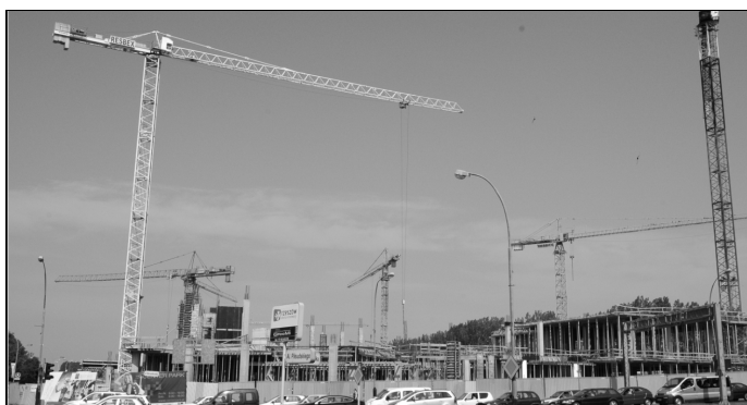
Rys. 3. „Galeria Rzeszów” w trakcie realizacji.
