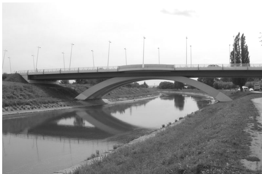
Rys.5. Pierwsze polskie konstrukcyjne zastosowanie betonu samozagęszczonego – Most Zamkowy w Rzeszowie
