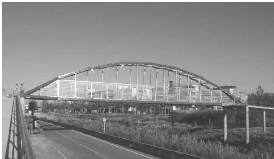
Rys.3. Kładka dla pieszych Lleida w Hiszpanii wybudowana w całości z kompozytów
