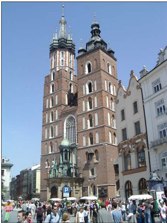
Rys. 1. Zachodnia fasada kościoła Mariackiego – po lewej stronie hejnałica, po prawej dzwonnica
