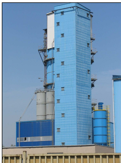
Rys. 1. Węzeł z instalacją do mechanicznego aktywowania popiołu lotnego na terenie elektrociepłowni Jaworzno III
