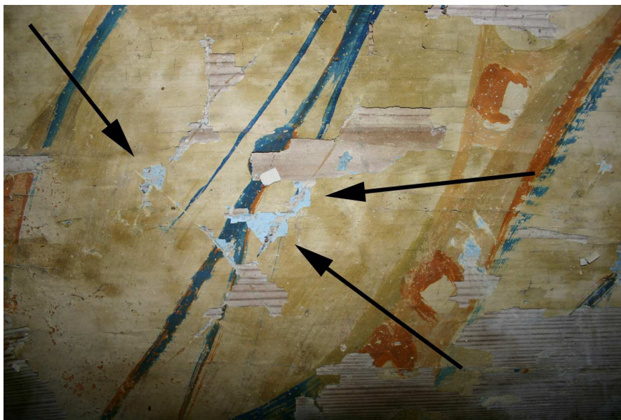
Rys. 12. Oryginalna polichromia temperowa widoczna pod olejnym przemalowaniem z XX w. wykonanym na ścianach prezbiterium
