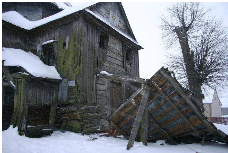
Rys. 13. Zawalona kruchta przylegająca do babińca od strony zachodniej (luty 2010 r.)
