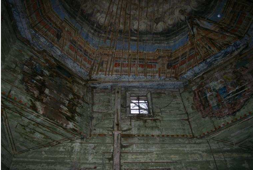
Rys. 16. Zniszczenia polichromii występujące w miejscach styku poszczególnych desek – widok na ścianę i kopułę od strony północnej
