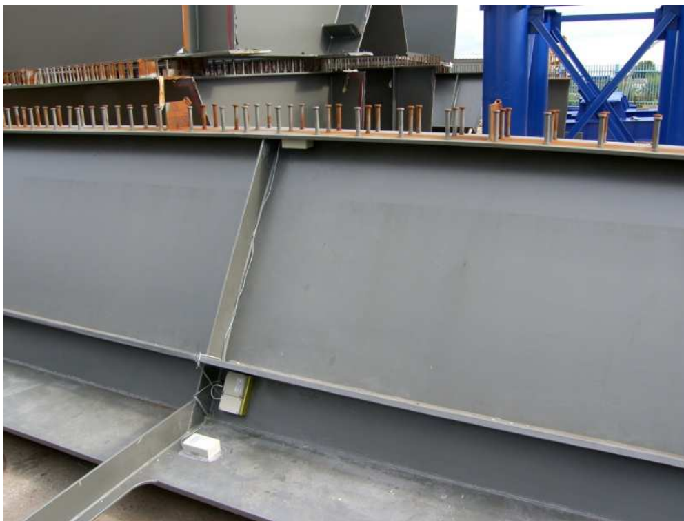
Rys. 3. Zainstalowane czujniki na konstrukcji w wytwórni
