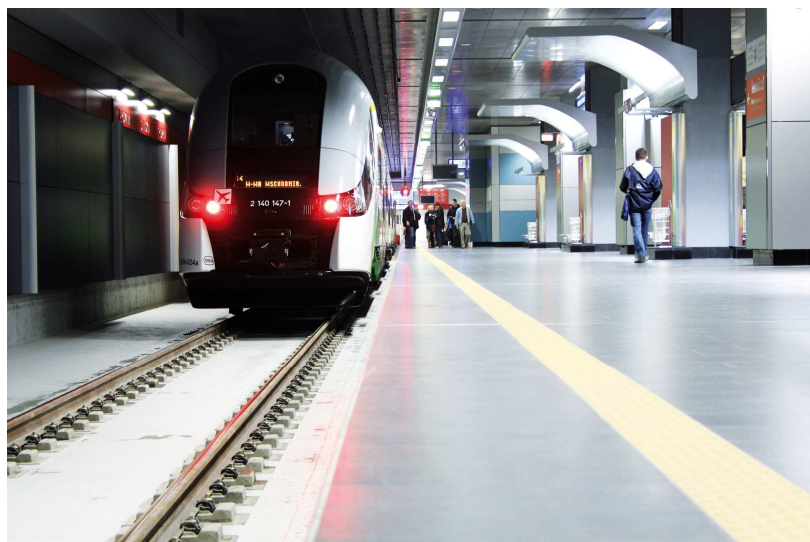
Fot. 6. Nawierzchnia bezpodsypkowa w systemie EBS na stacji kolejowej – Tunel na lotnisko Okęcie
