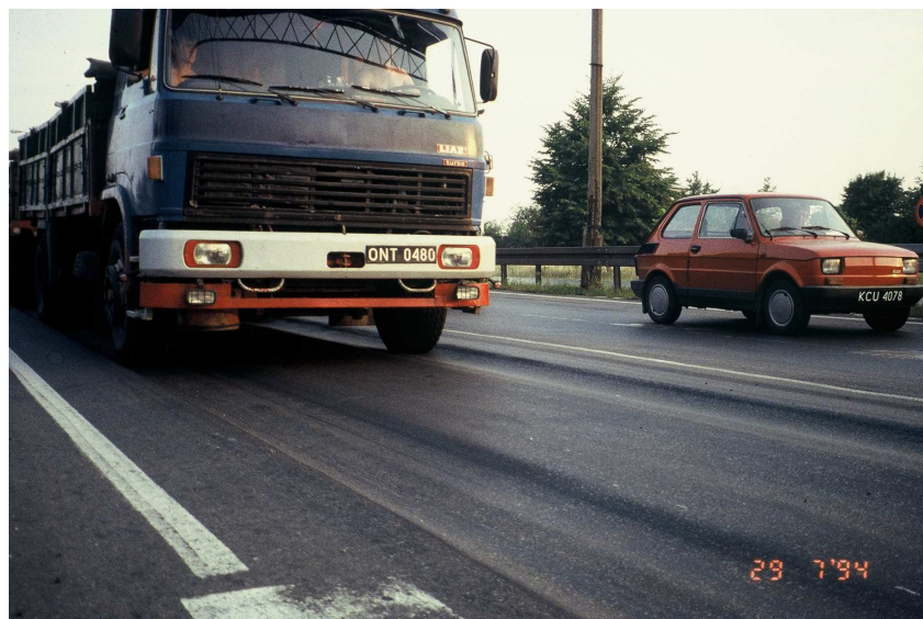
Fot. 1. Przykład zdeformowanej (skoleinowanej nawierzchni asfaltowej w 1994 r.
