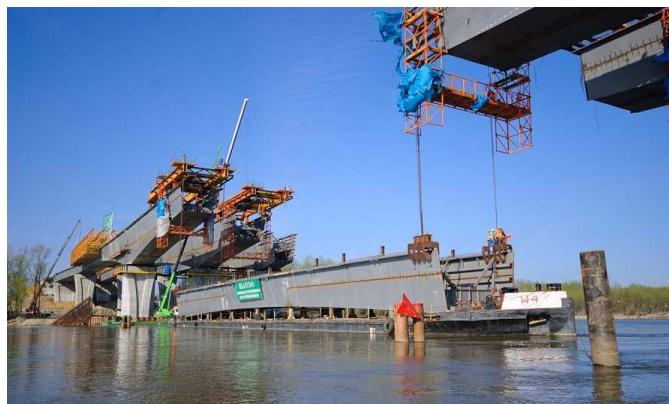
Fot. 24. Most Północny w Warszawie – podnoszenie segmenty przęsłem nurtowego
