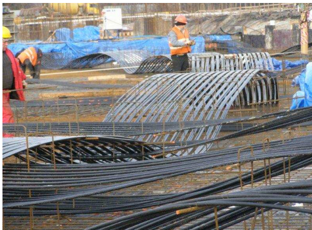
Rys. 19. Fundament hali sportowej w Krakowie Czyżynach - trasowanie kabli fundamentowej.
