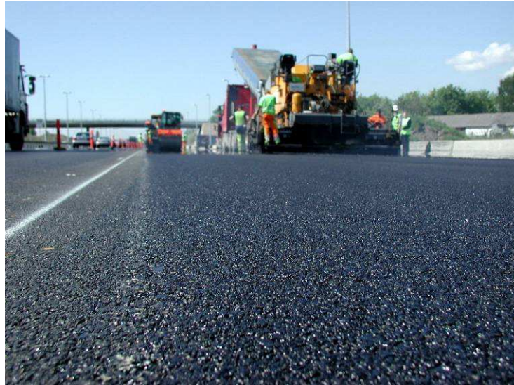
Rys. 5. SkanTOP XL Silence posiada unikalną drobnoziarnistą strukturę powierzchni, która skutecznie redukuje hałas uliczny opon/nawierzchni drogowej.
