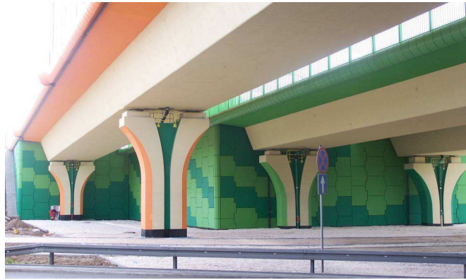
Fot. 23. Warszawa – Węzeł Marsa. Przyczółki mieszane
