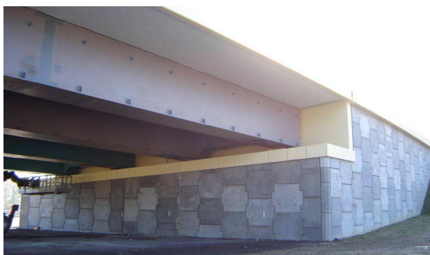
Rys. 22. Stróża – Wiadukt w ciągu „zakopianki”. Przyczółek mieszany ze schowanymi w nasyp z gruntu zbrojonego palami.
