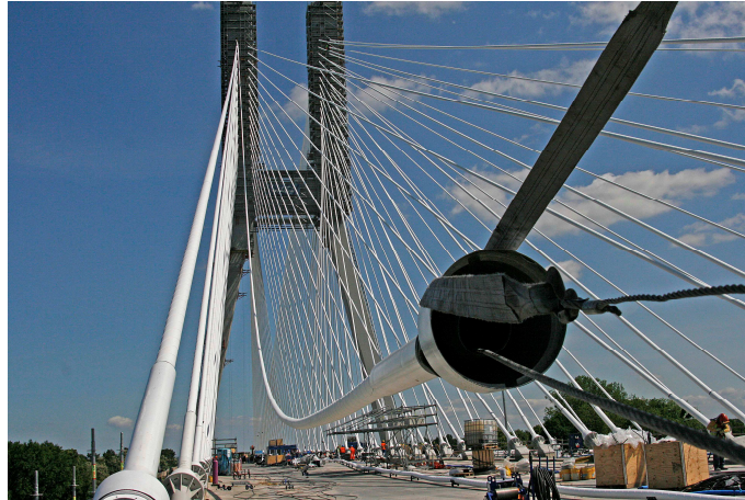
Rys. 12. Most główny obiektu MA-21' – montaż osłony wanty
