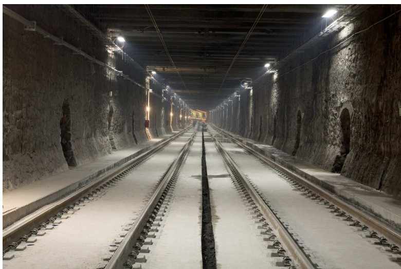
Fot. 9. Zastosowanie nawierzchni bezpodsypkowej w systemie EBS w tunelu Średnicowym w Warszawie
