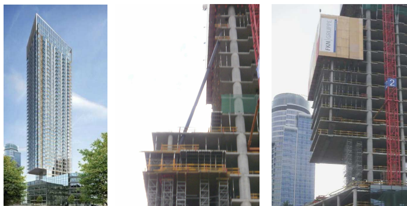
Rys. 18. Budynek Cosmopolitan Twarda 2/4 – wizualizacja, oraz budowa podwieszanych kondygnacji
