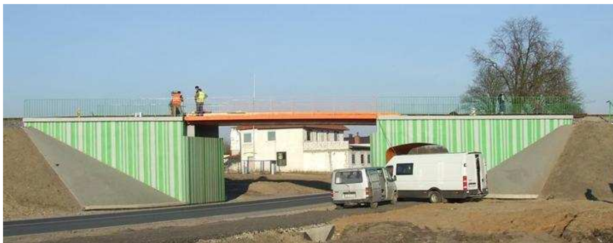
Fot. 4. Obiekt inżynierski z nawierzchnią wykonaną w systemie szyny w otulinie ERS – Szydłowo, linia nr 403
