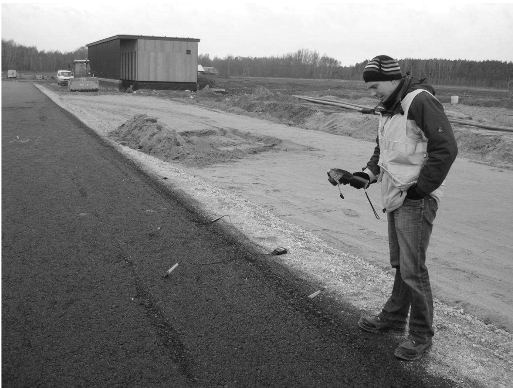
Rys. 8. Badania termowizyjne przeprowadzone na jednym z prototypowych odcinków testowych wykonanych w okresie jesiennym (2011) przy obniżonej temperaturze wbudowania. Źródło: Mostostal Warszawa S.A.
