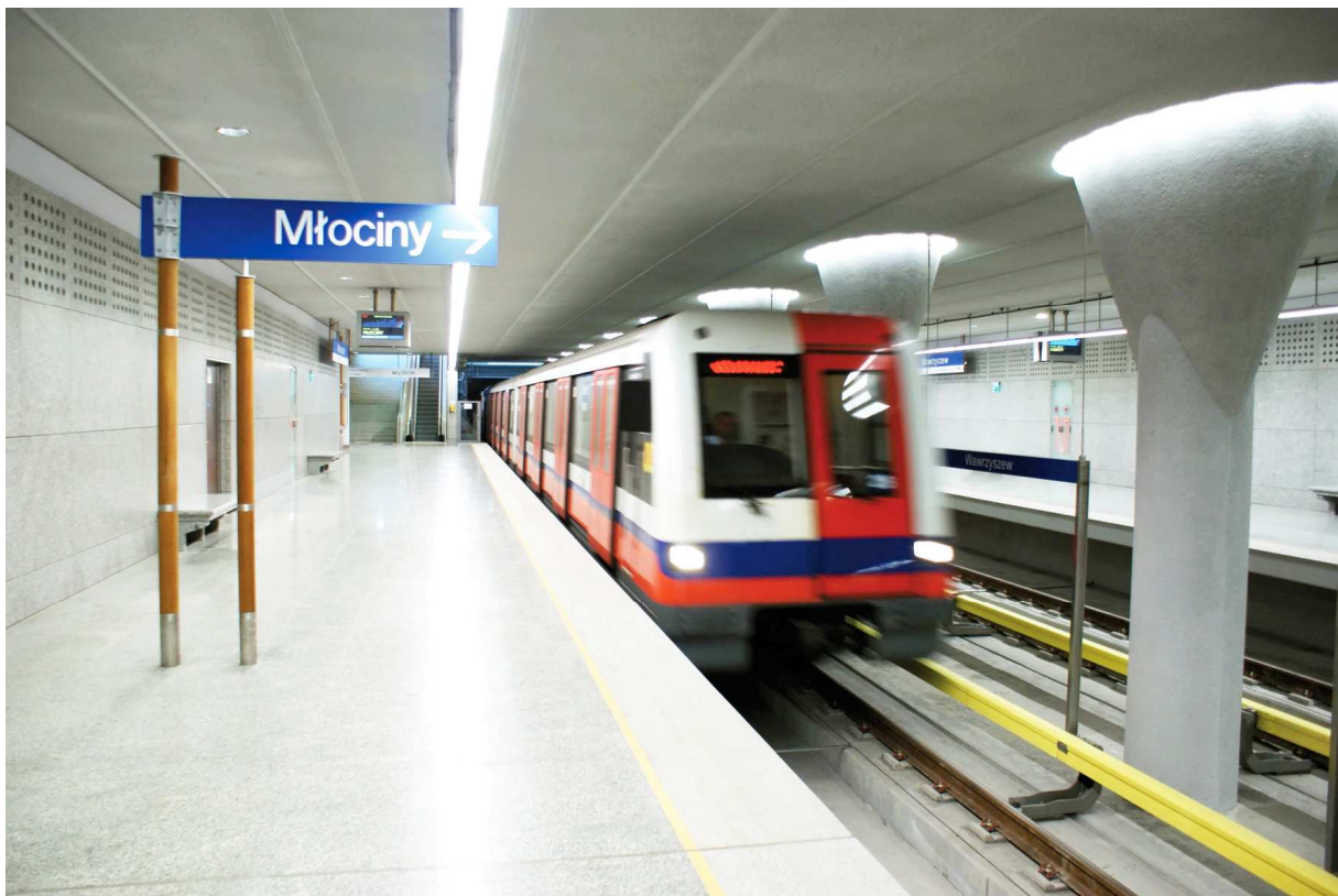
Fot. 10. Zastosowanie nawierzchni bezpodsypkowej w systemie EBS w odcinku bielańskim Metra Warszawskiego
