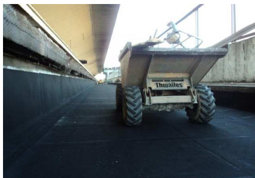
Fot. 14. Zastosowanie mat wibroizolacyjnych TRACKELAST w nawierzchni Dworca Kraków Główny oraz Centralnej Magistrali Kolejowej
