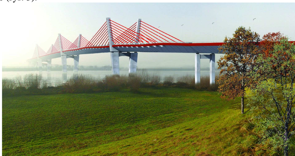
Rys. 3. Most extradosed przez Wisłę w Kwidzynie: 70+130+204+204+130+70m (wizualizacja)
