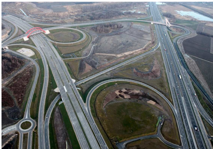
Rys. 1. Węzeł Sośnica – przecięcie A1 z A4 [1].
