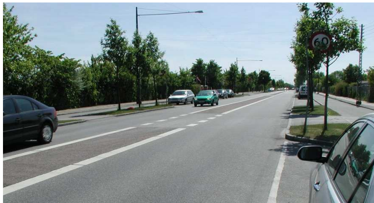
Rys. 3. Odcinek testowy SILVIA usytuowany w Kopenhadze oficjalnie używany jako odcinek odniesienia do kalibracji pomiaru hałasu przyczepami CPX pracującymi w Danii.
