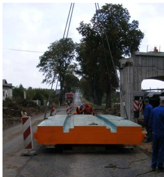
Fot. 2. Linia kolejowa nr 403, Szydłowo – prefabrykowane przęsło mostu z nawierzchnią w systemie szyny w otulinie
