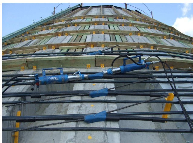
Rys. 20. Przykład wzmocnienia konstrukcji żelbetowej systemem NSS.
