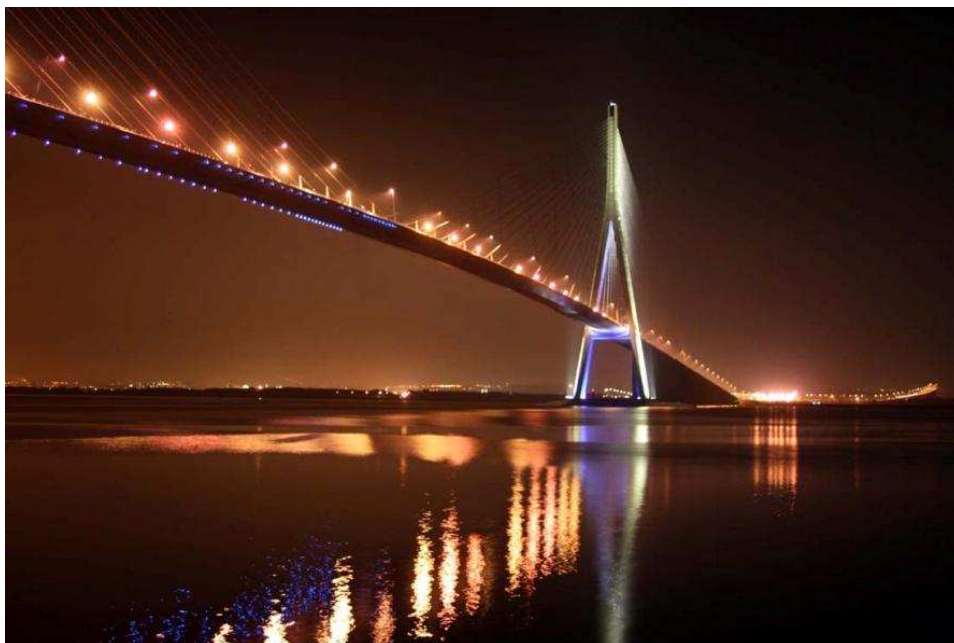
Rys. 5. Most Normandie, przęsło główne 856 m, 1995 rok ( http://en.wikipedia.org )
