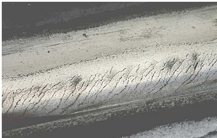
Rys. 4. Uszkodzenie szyny w postaci rys (fot. H. Bałuch)
