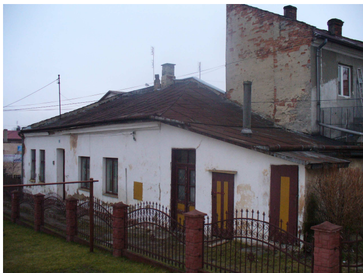
¶ Rys. 2. Budynek przy ul. Piekarskiej 13 przed przebudową Fig. 2. The building Piekarska st. 13 before the conversion
