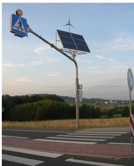
Fot.1. Zestaw hybrydowy: element fotowoltaiczny (oraz mały wiatrak) produkujący energię dla oświetlenia znaku przejścia dla pieszych nad ulicą. W tle tradycyjny krajobraz Świnnej Poręby. Zdjęcie wykonane przy trasie Świnna Poręba-Wadowice na południu Polski.. Zdjęcie: autorka Fig.1. Hybrid: Photovoltaic element (and small windmill), producing energy for the light of the sign of pedestrian crossing on the road. In the background the traditional landscape of Świnna Poręba. The photo made by the car way Świnna Poręba – Wadowice, on the south of Poland.
