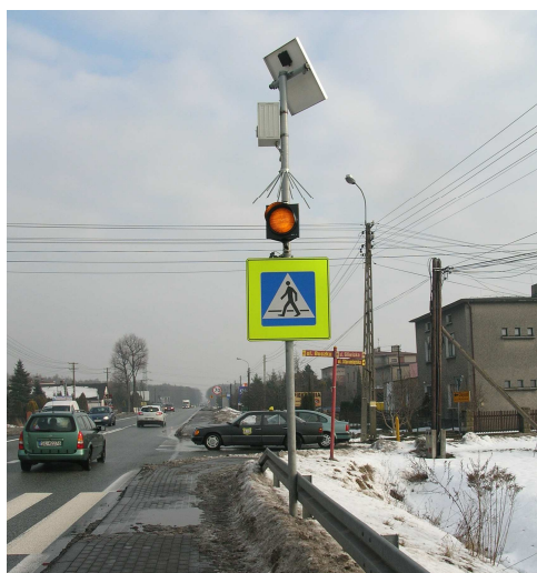
Fot.5. Widok ulicy: współczesny wizerunek drogi na odcinku Gliwice-Mikołów na południu Polski. Z przodu pośrodku: element fotowoltaiczny dostarczający nawet zimą energii dla oświetlenia znaku ulicznego na przejściu dla pieszych. Zdjęcie: autorka Fig. 5. Street-view: The present image of the street by the car way Gliwice – Mikołów in the south of Poland. In the foreground: The photovoltaic element providing energy for the street sign next to pedestrian crossing – working even in winter. Photo: The author
