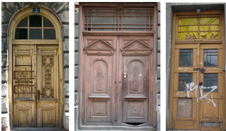
Fot. 1. Jarosław, zniszczone drzwi eklektyczne przy ulicach: Św. Ducha 4 i Kraszewskiego 6 oraz modernistyczne przy ul. Węgierskiej 3, fot. J. Stęchły Photo 1. Jarosław, damaged eclectic doors at the streets: Św. Ducha 4, Kraszewskiego 6 and modernist door at Węgierska 3, photo by J. Stęchły
