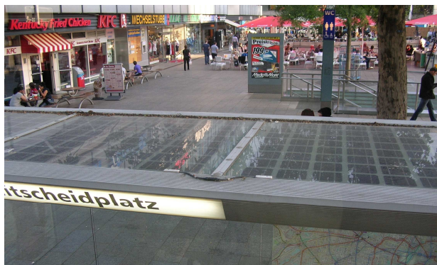
Fot. 5. Berlin, dzielnica Charlottenburg w roku 2011: przystanek autobusowy obsługiwany energią słoneczną pozyskiwaną z elementu fotowoltaicznego umieszczonego na dachu przystanku. Tu ze źródeł odnawialnych pochodzi prąd dla oświetlenia miejsc siedzących oraz zasilanie punktu informacyjnego. Foto: autorka
