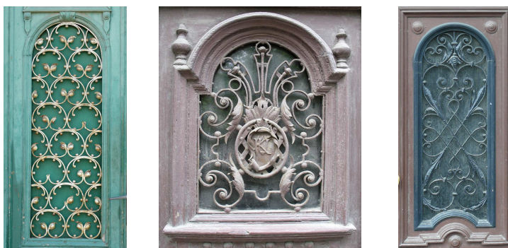
Fot. 2 Kraty w prześwitach jarosławskich drzwi z XIX/XX w. przy ulicach: Lubelska 19, Kraszewskiego 13 i Grunwaldzka 3, fot. J. Stęchły
