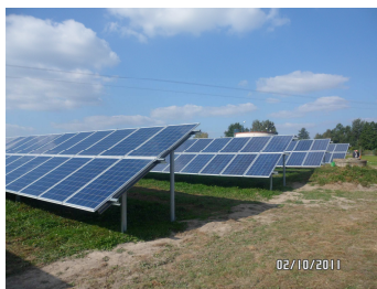
Rys. 7. Widok rzędów paneli stacjonarnej farmy PV. Figure 7 View of rows of panels in the stationery PV farm.
