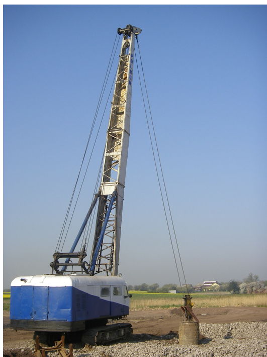
Rys. 2. Maszyna do wbijania kolumn kamiennych i odkrywki kolumn kamiennych (Fot. własne)
