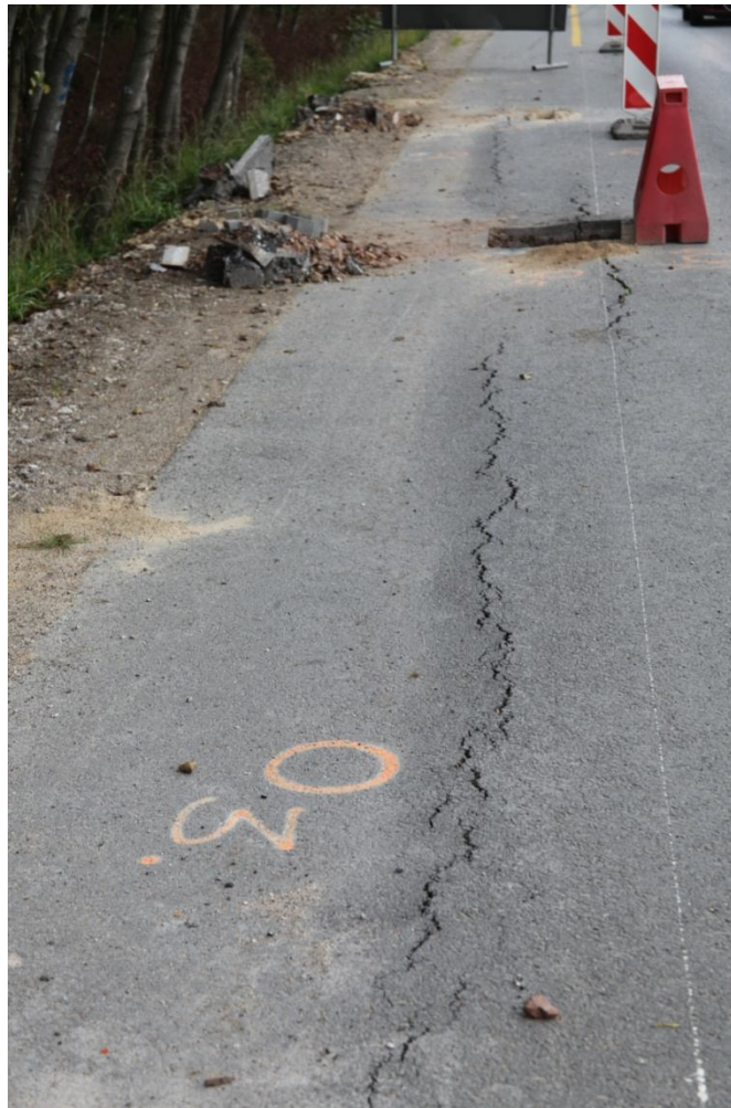
Rys. 1. Przykład naruszenia nośności podłoża konstrukcji drogi S5 po pełnej wymianie organicznego gruntu (torfu), [1].
