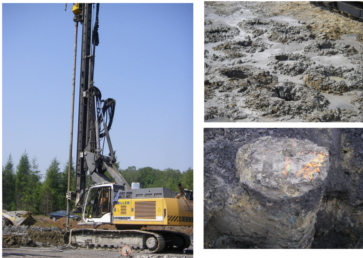
Rys. 3. Maszyna do wglębnego mieszania gruntu, wykonane „świeże” kolumny DSM i odkrywka kolumny DSM (Fot. własne)
