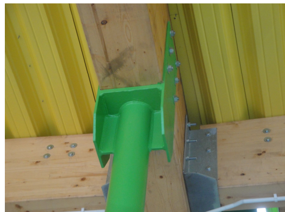
Rys. 15. Połączenie słup - dźwigar
