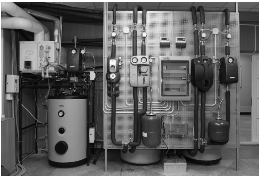
Rys. 1. Widok nowej instalacji hybrydowej z OZE w PPAR [Źródło: AMT-Projekt] Fig. 1. View of the new hybrid installation with RES in PPAR [Source: AMT-Projekt]
