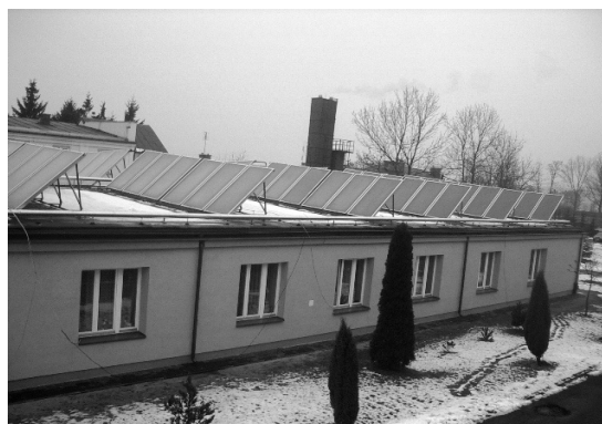
Rys. 2. Sekcja płaskich kolektorów słonecznych na dachu budynku B Fig. 2. Flat plate solar collectors on the roof
