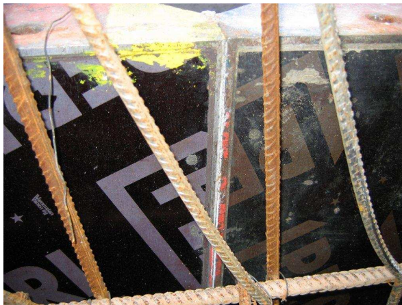
Fot. 3. Przykład zastosowanego deskowania Fot. 3. Example of the sideplanking
