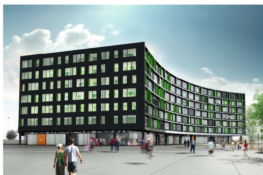
Rys. 2. Green Horizon, budynek biurowy w Łodzi; pre-certyfikacja LEED gold (www.skanska.pl)
