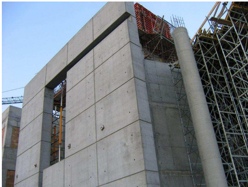
Fot. 5. Ściana wykonana z betonu zgodnego z recepturą ASCC Fot. 5. The wall is made of concrete that is compatible with recipe ASCC
