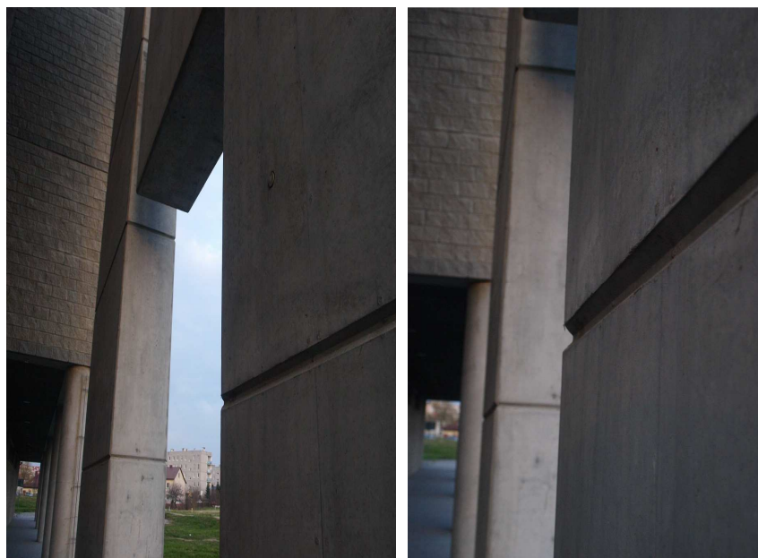
Fot.1 Sąd Rejonowy w Rzeszowie [8] Fot.1 District Court in Rzeszow [8]
