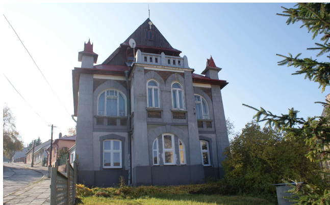
Fot. 1. Elewacja frontowa domu przy ulicy Tatarskiej 26 w Przemyślu Fot.1. Front elevation of Tatarska 26 house in Przemyśl.
