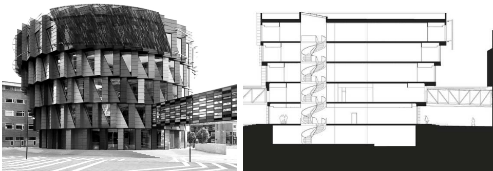
Rys. 5. Budynek biurowy w Kuggen – autorzy: Wingardh Arkontor (fot. e-architect.co.uk)
