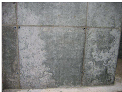
Fot. 1. Efekt pierwszego betonowania Fot. 1. The effect of the first concrete work
