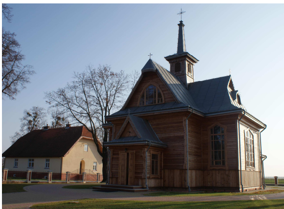
Fot. 2. Kościół pod wezwaniem Matki Boskiej Śnieżnej w Miększu Nowym, widok od strony północno – zachodniej
