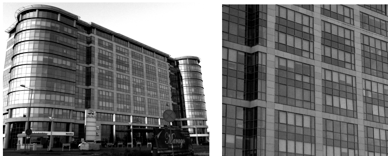
Rys. 1. Przykład budynku biurowego w Katowicach bez rozwiązań zacieniających – wewnętrzne żaluzje w większości okien (fot. M. Burmistrz)
