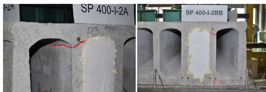
Rys. 8. Zarysowanie w obszarze skrajnego kanału w płytach serii SP 400-I
