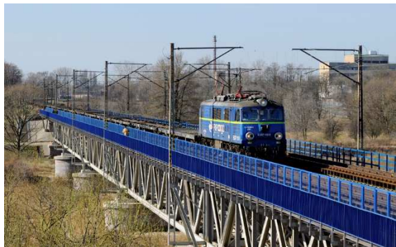
Rys. 3. Widok ogólny mostu
