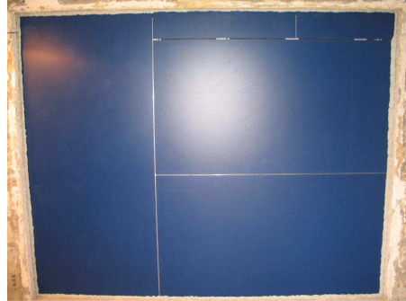
Rys. 6. Ściana z ociepleniem w technologii lekkiej suchej podczas badań laboratoryjnych, na podstawie [7]
