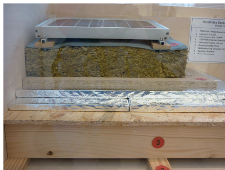
Rys. 3. Model stropodachu pełnego Plus-Energie-Haus
