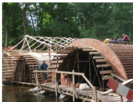
Rys. 7. Most w Pilcu –deskowanie żelbetowych łuków
