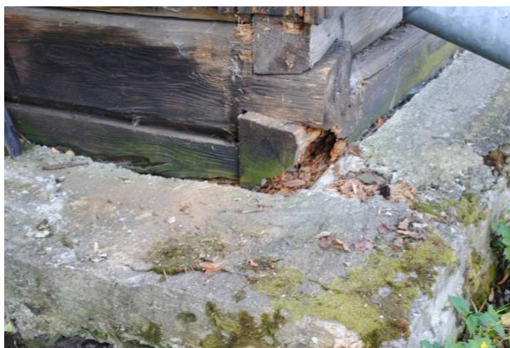
Rys. 2. Widok belek podwalinowych, strona wschodnia, 2012, fot. Ł. Gołda
