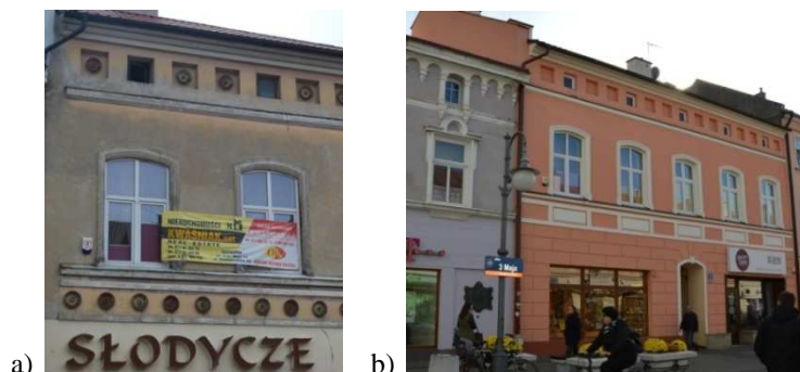
Rys. 7. Kamienica nr 3 a) przed remontem [10]; b) po remoncie w 2012 r. [6]
