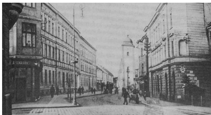
Rys.8. Widok na kamienicę nr 13 (po prawej) z początku XX w. [3]
