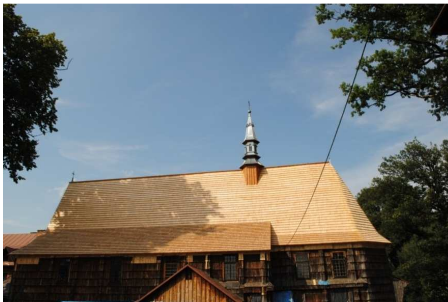
Rys. 7. Widok nowego pokrycia gontowego więźby dachowej z oblachowaniem sygnaturki, 2014, fot. Ł. Gołda
