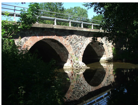
Rys. 4. Most w Pilcu – widok mostu przed przebudową
