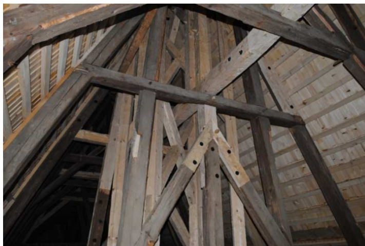
Rys. 4. Widok scalenia protezy z pierwotnym materiałem za pomocą kutych śrub, 2014, fot. Ł. Gołda
