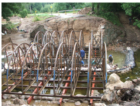
Rys. 6. Most w Pilcu – konstrukcja wsporcza deskowań
