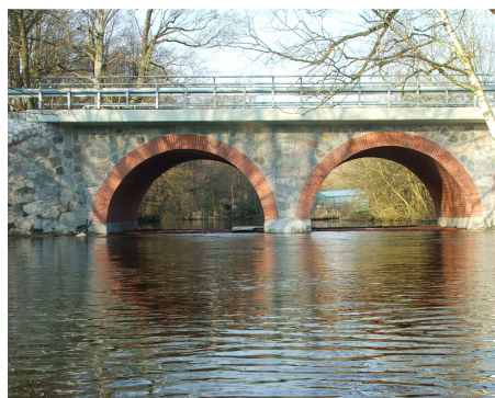
Rys. 5. Most w Pilcu – widok przebudowanego obiektu
