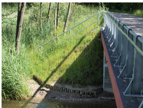
Rys. 9. Most w Jędrzejkach – obsadzenie skarp roślinnością
