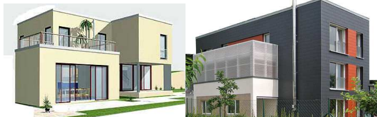
Rys. 5. Przykłady przebudowanych budynków, na podstawie [2, 5]
