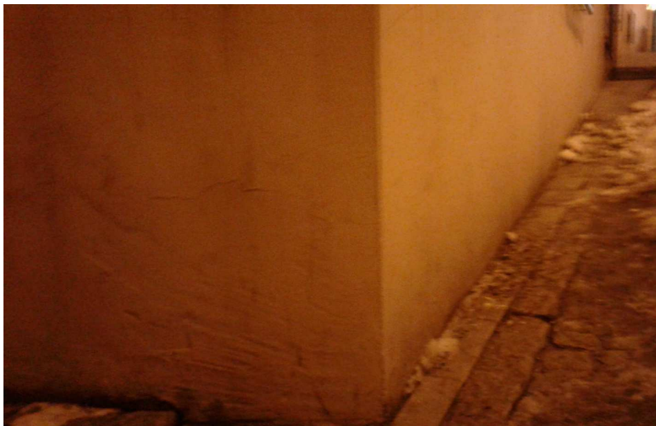
Rys. 8. Nieprawidłowe uzupełnienie skorodowanego tynku, fot. autor, Luty 2017
