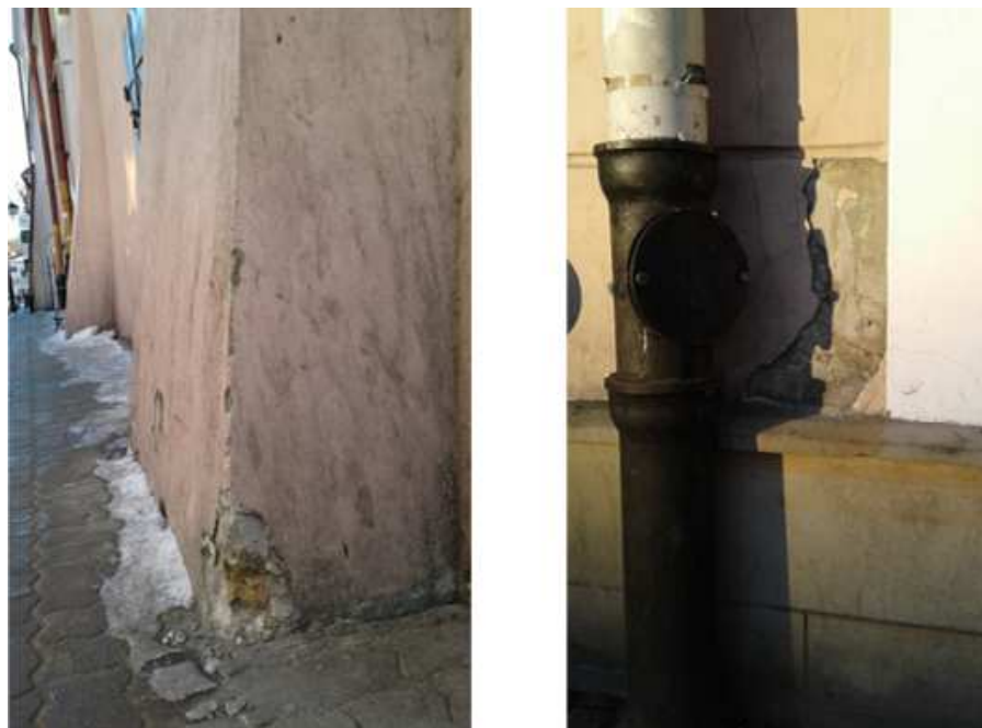
Rys. 4. Korozja tynku, fot. autor, Luty 2017
