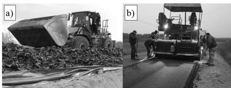
Rys. 3. Etapy realizacji nasypu drogowego: a) wyrównanie kruszywa gumowego, b) układanie nawierzchni, na podstawie [27]
