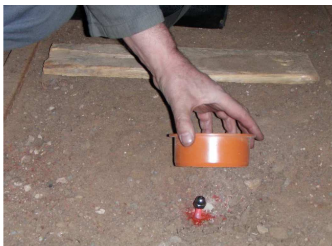
Rys. 5. Spągowy znak pomiarowy z osłoną
