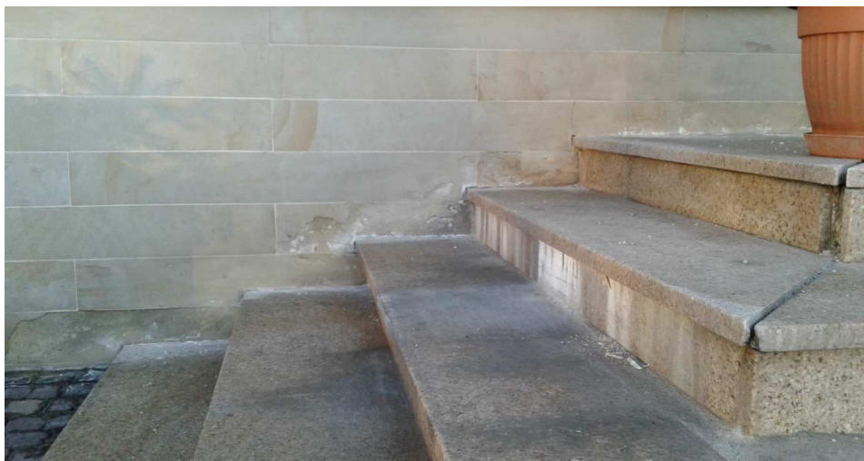
Rys. 5. Korozja cokolu, fot. autor, Luty 2017
