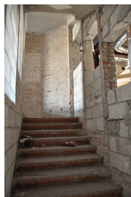
Rys. 8. Nowa Sól, dawny szpital powiatowy, klatka schodowa po stronie północnej
