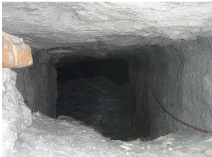
Rys. 4. Zasypany fragment przekopu
