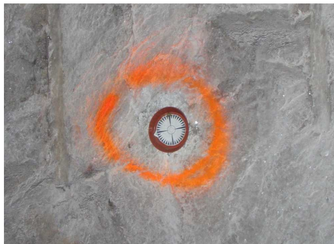
Rys. 7. Tarcza sygnalizacyjna zamocowana na caliźnie solnej
