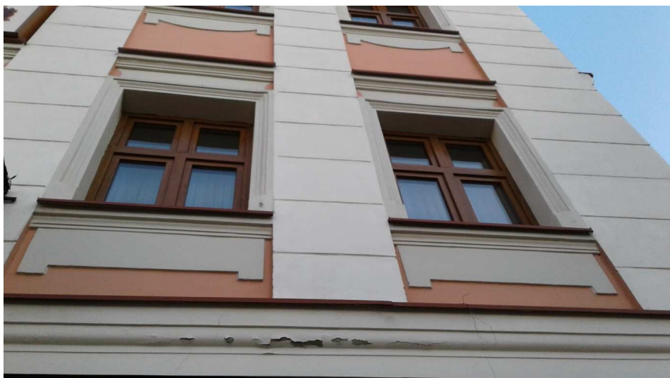
Rys. 6. Uszkodzony gzyms, fot. autor, Luty 2017
