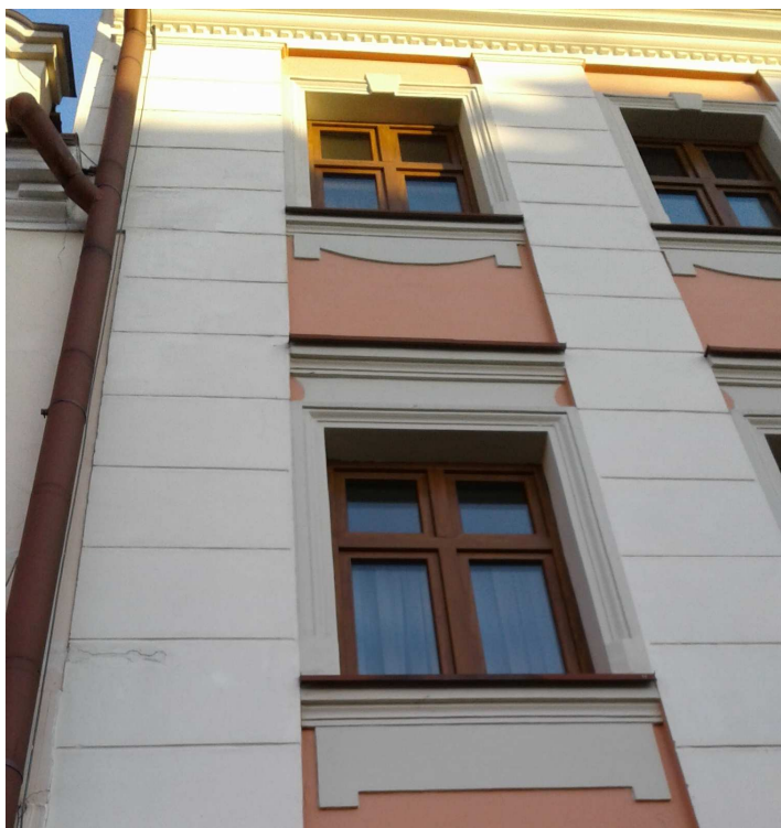
Rys. 7. Zatarcie na gładko, fot. autor, Luty 2017
