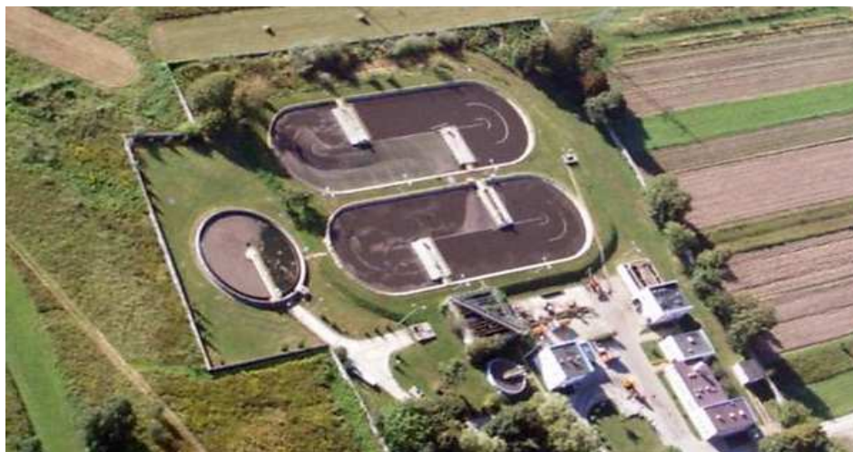
Rys. 1. Oczyszczalnia ścieków w Nisku [5]
