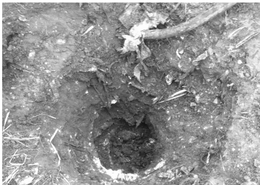
Rys. 5. Stan odpadów nawierconych podczas montowania sond monitoringowych
