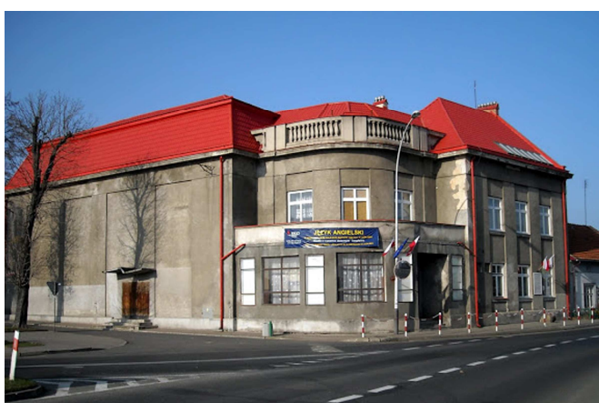
Rys. 16. Widok „Sokoła” w Sieniawie od strony południowej przed interwencją konserwatorską, fot. D. Kuśnierz-Krupa, 2006
