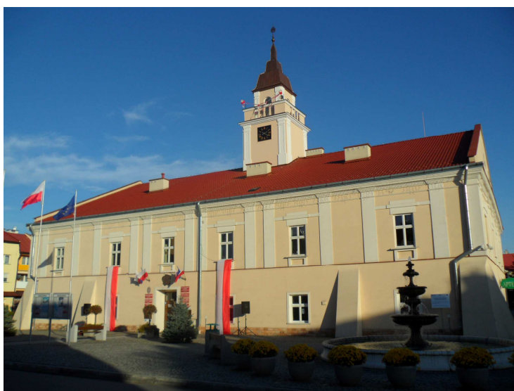
Rys. 12. Sieniawa – ratusz od strony południowo-zachodniej po interwencji konserwatorskiej, fot. D. Kuśnierz-Krupa, 2012
