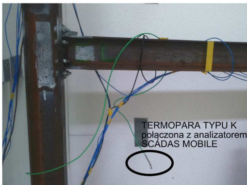
Rys. 6. Termopara połączona z analizatorem SCADAS Mobile
