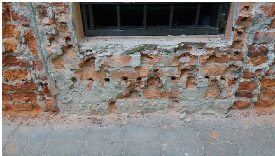
Rys. 7. Iniekcja, fot. autor, 2015
