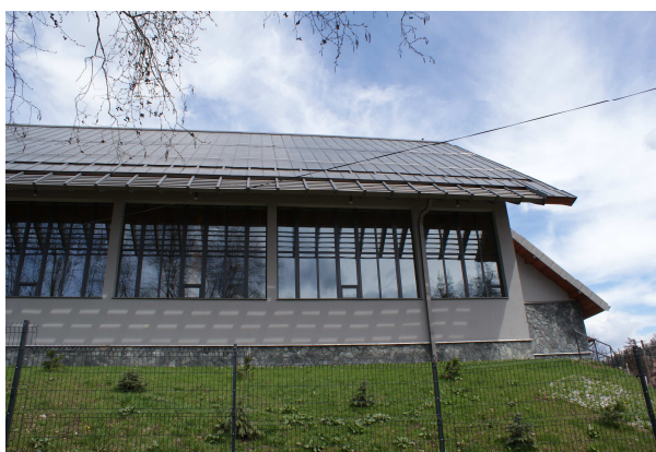
Fot. 1. Widok hali sportowej przy budynku Zespołu Szkół Ekonomicznych w Nowym Targu od strony południowo-zachodniej, fot. M. Krupa 04.2012
