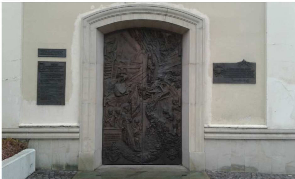
Rys. 1. Zachodnia elewacja wieży, fot. autor, październik 2016
