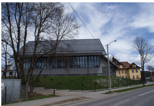
Fot. 2. Widok hali sportowej przy budynku Zespołu Szkół Ekonomicznych w Nowym Targu od strony południowo-zachodniej, fot. M. Krupa 04.2012
