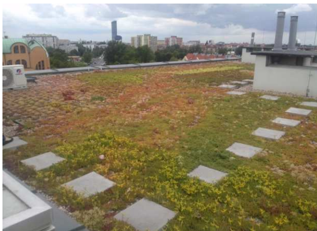
Fot. 2. Współczesny ekstensywny zielony dach na dachu płaskim
