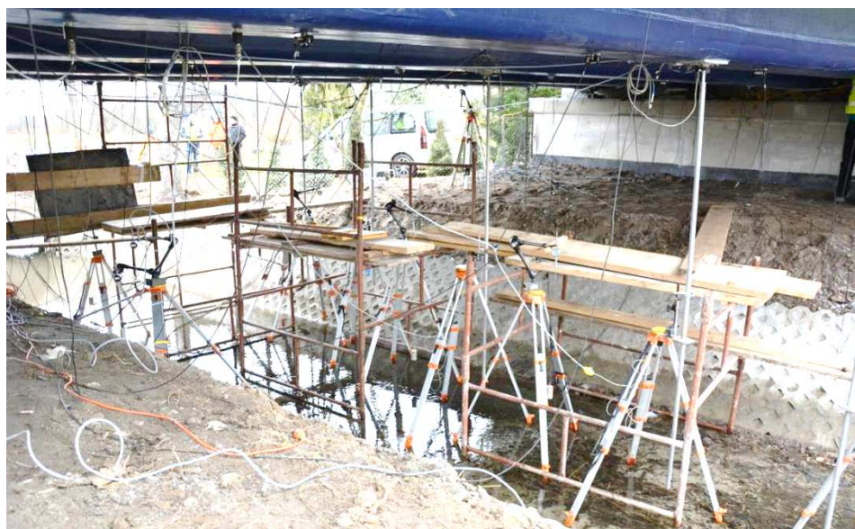
Rys. 3. Stanowisko pomiaru przemieszczeń pionowych dźwigarów
