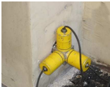
Rys. 3. Sposób mocowania czujników do konstrukcji
