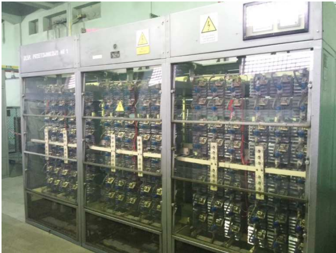
Rys. 1. Zespół prostownikowy typu PK 17/3,3-3
