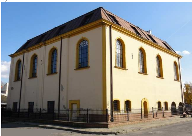
Rys. 2. Elewacje: południowa od strony ul. Opolskiej (a), północna i zachodnia od strony Placu Bóżnic (b)
