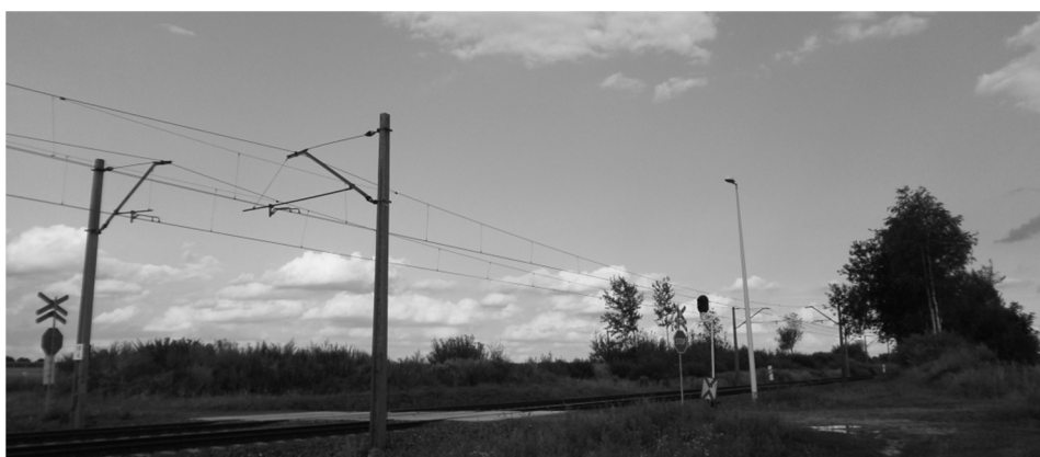
Rys. 5. Przejazd kolejowo-drogowy kategorii D (fotografia własna)
