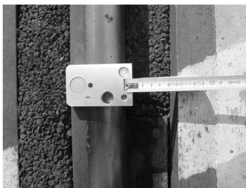
Rys. 10. Pomiar szerokości żłobków przejazdowych z użycie MMS i metra zwijanego (fotografia własna)
