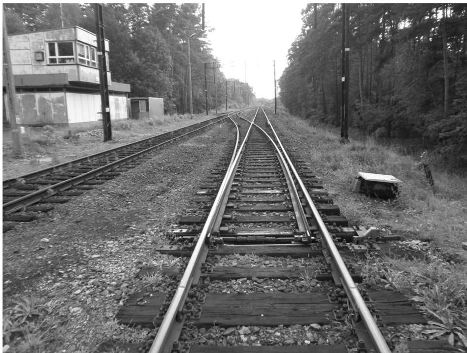
Rys. 2. Rozjazd zwyczajny nr 1 typu S60 – 1:9 – 300 (fotografia własna)
