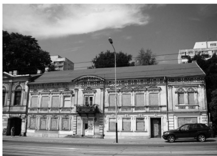
Rys. 6. Kamienica Beera przy ul. Piotrkowskiej 243 przed remontem
