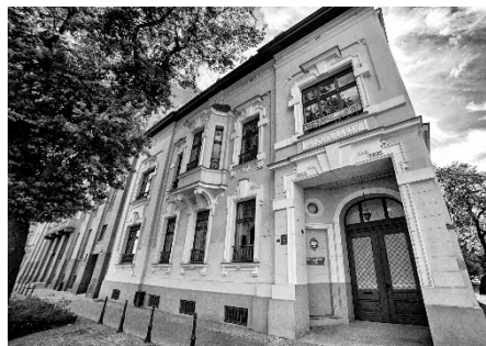
Rys. 11. Kamienica przy al. Kościuszki 81 po remoncie; źródło: fot. autorki
