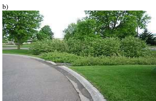
Rys. 6. Przykładowe rozwiązanie niecki bioinfiltracyjnej a) schemat zaprojektowanej niecki b) widok wykonanej niecki, na podstawie [21]
