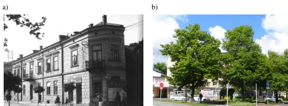
Rys. 6. Ulica Zamkowa: a) do lat 60. XX w. na podstawie [4], b) obecnie (fotografia autora) Fig. 6. Zamkowa street: a) until the 60s of the twentieth century [4], b) presently (author's photo)
