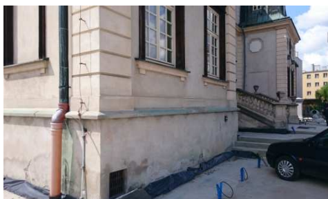
Rys. 9. Widok cokołu Pałacu przed remontem Fig. 9. View of the plinth before the repair
