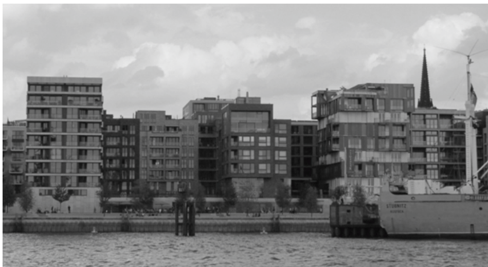
Fot. 2. Hafencity Hamburg – przykład nowoczesnej zabudowy mieszkaniowej, archiwum własne autora
