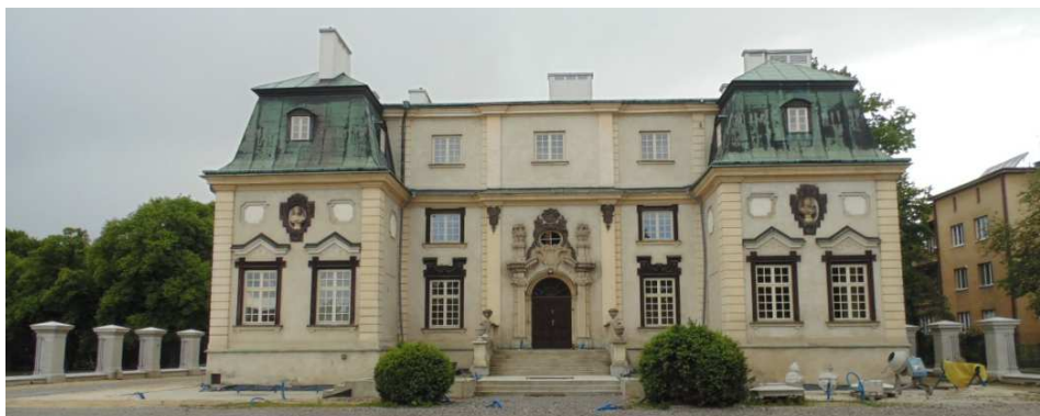
Rys. 1. Widok elewacji frontowej (wschodniej) przed remontem
