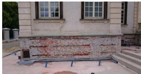
Rys. 10. Widok cokołu w trakcie remontu i zszywania rys Fig. 10. View of the plinth during the repair and stapling of the cracks
