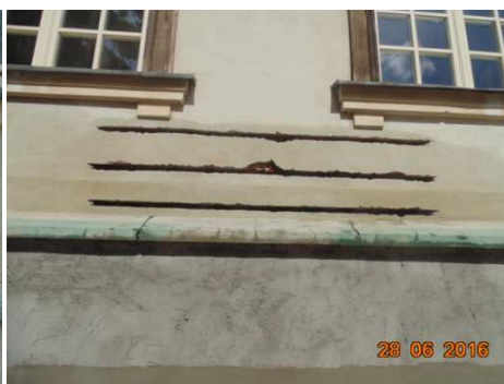
Rys. 12. Przykładowa naprawa rys elewacji Fig. 12. Example of façade cracks repair
