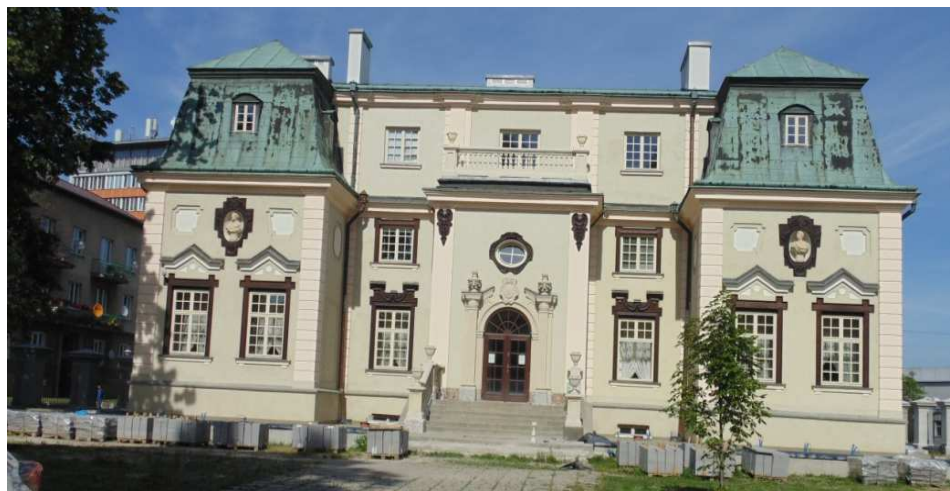
Rys. 13 Widok elewacji zachodniej po remoncie Fig. 13. View of the west façade after repairs
