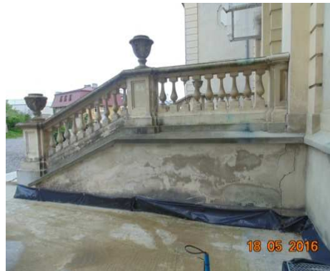
Rys. 2. Pęknięcia na styku schody - zasadnicza bryła budynku, zacieki → Fig. 2. Cracks at the junction of the stairs - building block, streaks →
