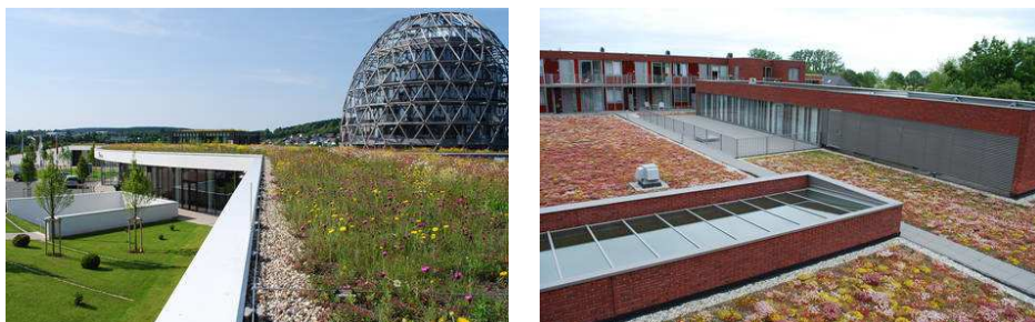
Rys. 18. Tradycyjny dach zielony, na podstawie [40]
