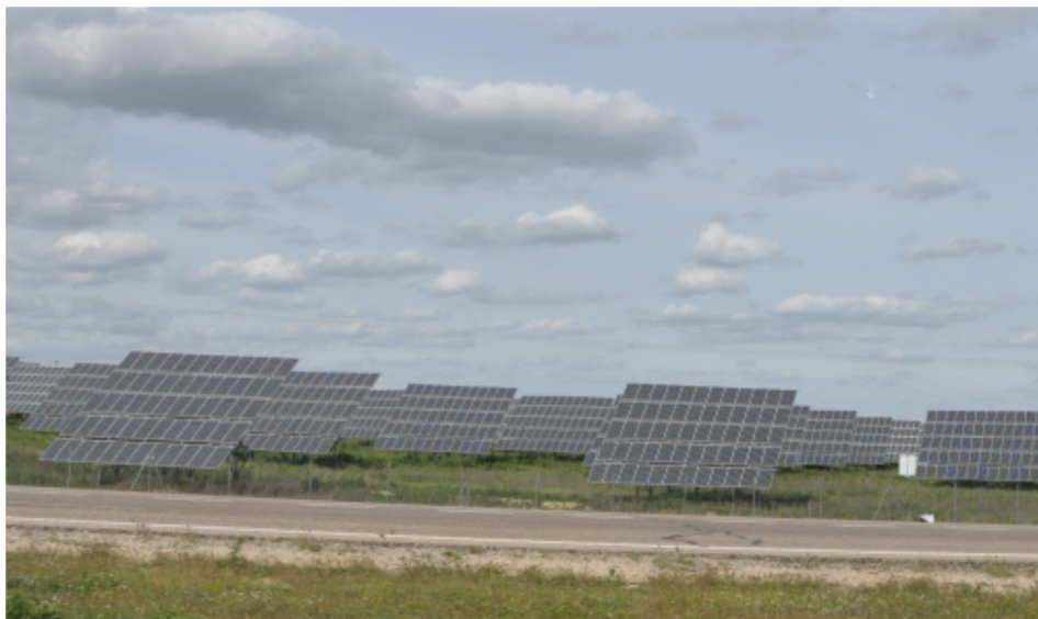
Rys. 4. Systemy fotowoltaiczne. Fot. autor
