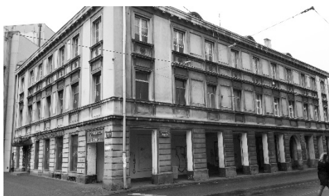
Rys. 8. Kamienica przy ul. Legionów 2 przed remontem
