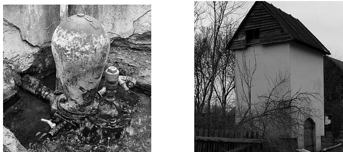
Rys. 1. System dystrybucji wody w Kajnach: taran (po lewej) i wieża ciśnień (po prawej)
