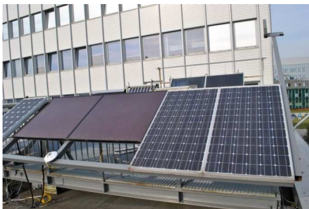
Rys. 3. System fotowoltaiczny Zakładu Termodynamiki i Mechaniki Płynów
