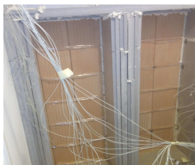
Rys. 2. Widok ścian od strony wewnętrznej
