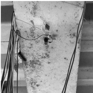
Rys. 7. Trójosiowy czujnik przyspieszeń zamocowany na dolnej półce poprzecznicy
