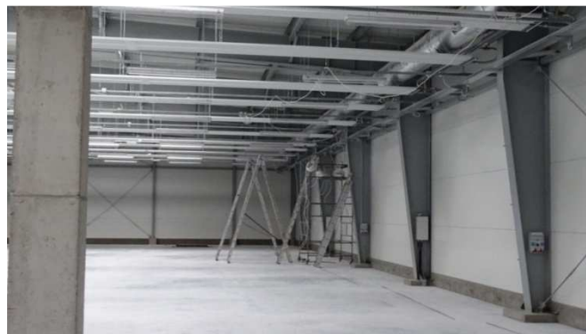
Rys. 3. Instalowanie podsufitowych promienników w trakcie robót
