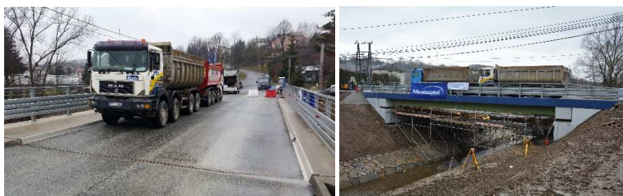
Rys. 7. Próbné obciążenie mostu i stanowisko pomiaru przemieszczeń
