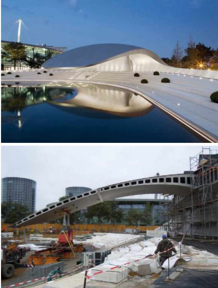
Rys. 1. The Porsche Pavillon (2004) – widok ogólny i konstrukcja przewieszenia typu monocoque; obrys rzutu przewieszenia 25 x 30 m; elementy konstrukcyjne i panele obudowy wykonano ze stali nierdzewnej gatunków 1.4301, 1.4571; zużycie stali nierdzewnej 425 t; lokalizacja Wolfsburg, Niemcy [19]
