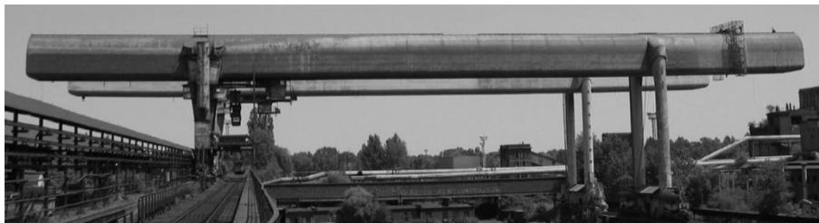
Rys. 1. Most przeładunkowy o konstrukcji powłokowej
