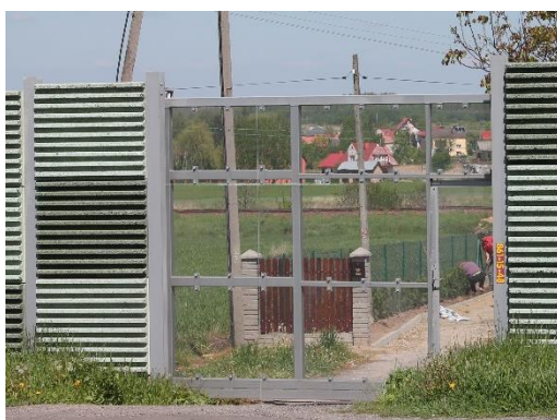
Rys. 2. Widok bramy wjazdowej
