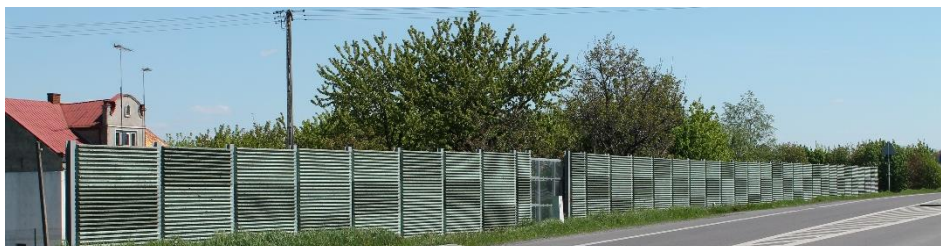
Rys. 1. Widok ekranu akustycznego od strony drogi
