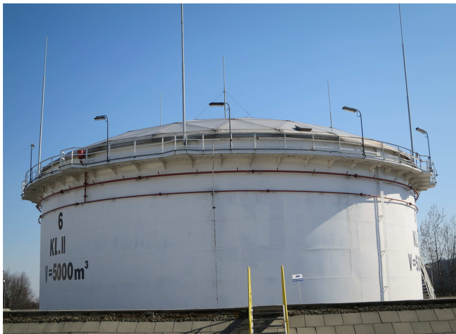
Rys. 5. Zbiornik stalowy z kopułą aluminiową i wewnętrznym dachem pływającym o pojemności 5000 m 3 przystosowany do magazynowania paliwa lotniczego typu JET (zdjęcie – J. Siudut)
