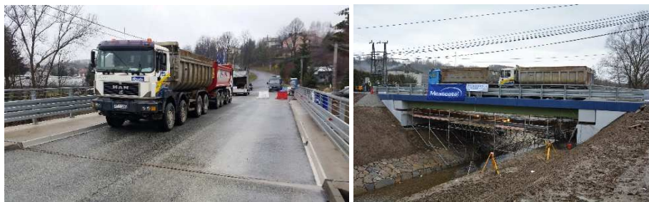
Rys. 7. Próbné obciążenie mostu i stanowisko pomiaru przemieszczeń
