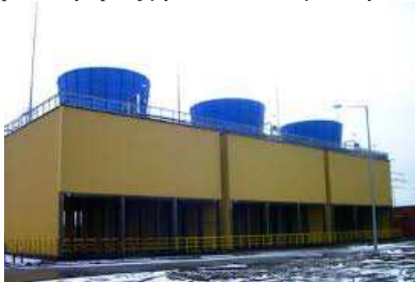
Rys. 2. Widok budynku chłodni wentylatorowej. Na dachu widoczne powłoki dyfuzorów [2]
