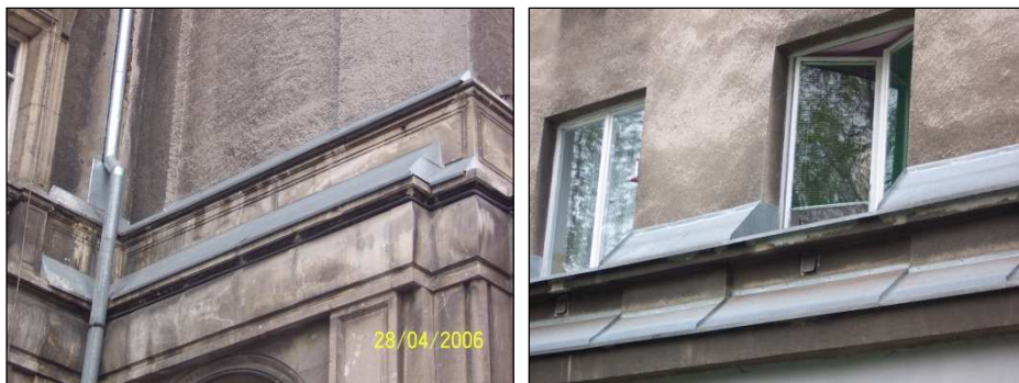
Rys. 3. Nowe obróbki blacharskie gzymsów na ścianach budynków mieszkalnych w najstarszej części Nowej Huty w Krakowie (fot. T. Kusionowicz)
