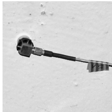
Rys. 8. Jednoosiowy czujnik przyspieszeń zamocowany od spodu płyty pomostu
