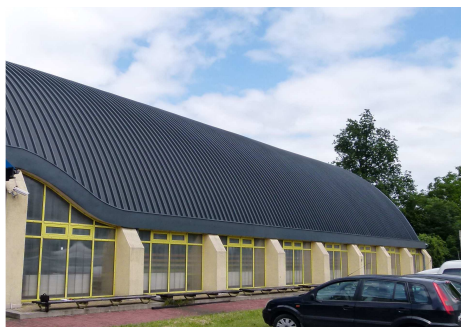
Fot. 1. Widok zewnętrzny obiektu
