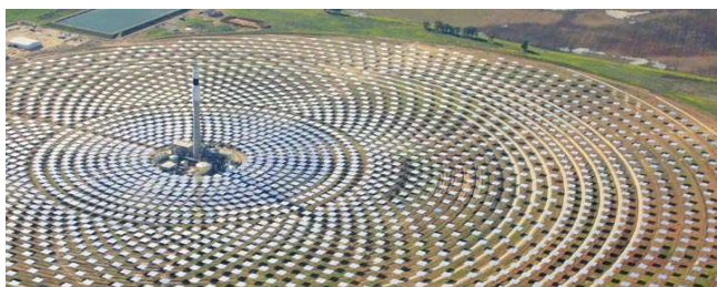
Rys. 1. Helioelektrownia typu wieżowego, pole heliostatów otacza wieżę słoneczną ze wszystkich stron, źródło: EcoGuard
