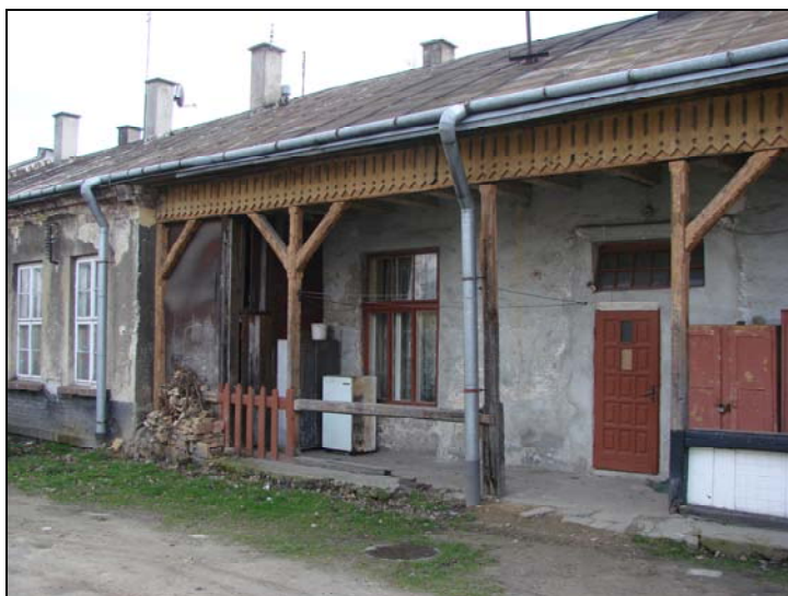
Fot. 20. Drewniane podcienia wejściowe
