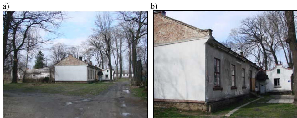
Fot. 21. Budynki osiedlowe z widoczną częścią sanitarną
