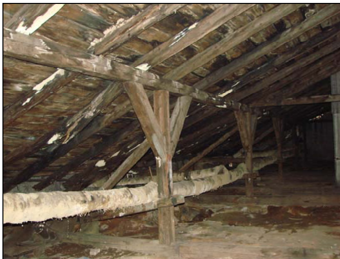
Fot. 29. Fragment więźby dachowej
