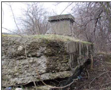
Fot. 10. Fragment stropu
