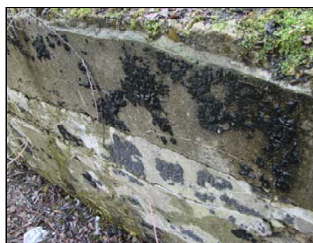
Fot. 13. Bitumiczne zabezpieczenie izolacyjne
