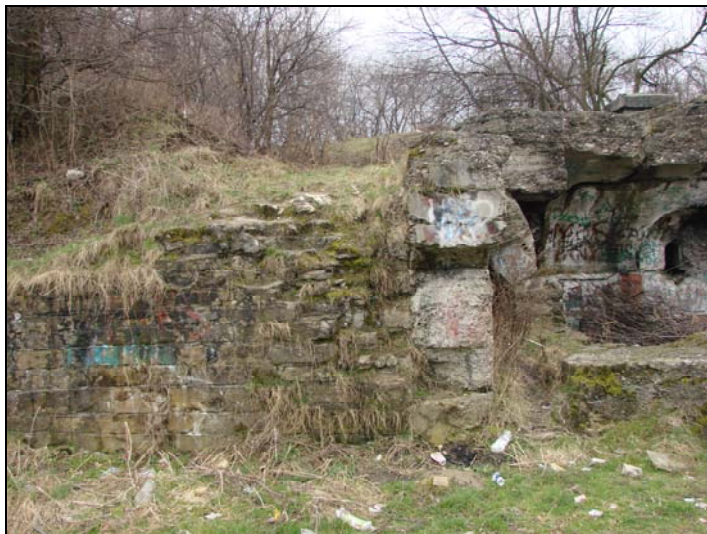
Fot. 14. Ściana oporowa z muru kamiennego
