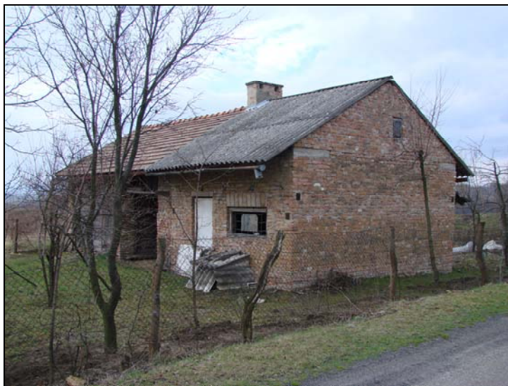
Fot. 7. Budynek wzniesiony z budowlanego materiału forttecznego na miejscu magazynu prochu
