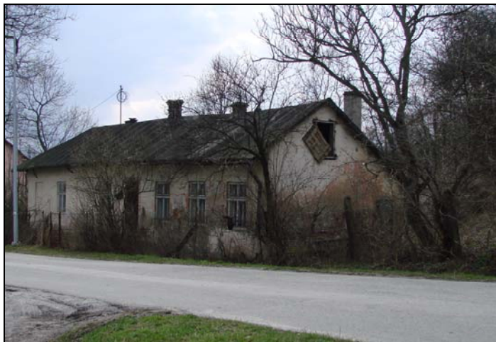
Fot. 3. Budynek wartowni przy ulicy Przemysława 25
