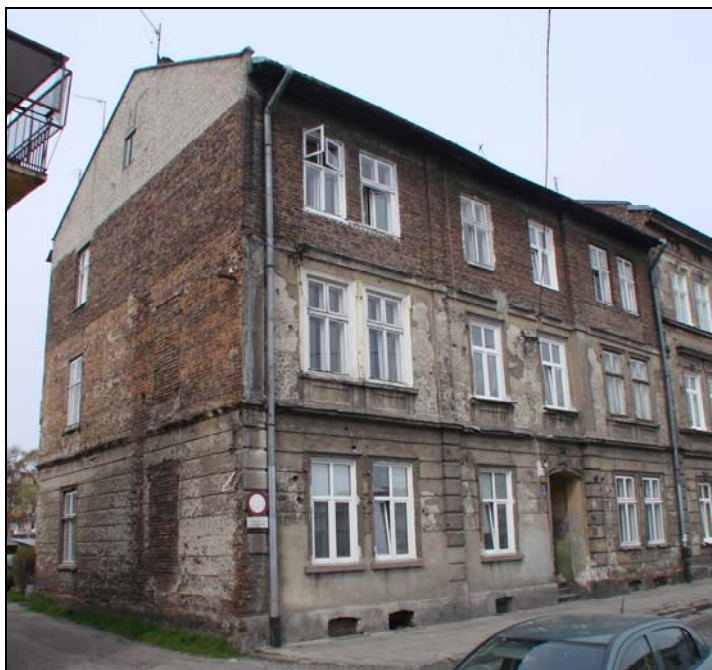
Fot. 26. Gmach Sądu Garnizonowego przy ulicy Rokitniańskiej 3
