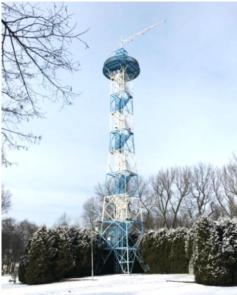
Ryc. 1. Wieża spadochronowa. Źródło: fot. autorka 01.2024
