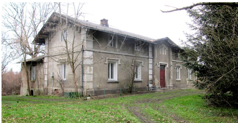
Ryc. 7. Oficyna wschodnia. Zdj. autorka, marzec 2024. Fig. 7. Eastern outbuilding. Photo author, March 2024.
