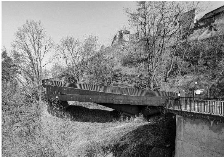
Ryc. 8. Dobczyce – kładka dla pieszych, Fot. autora Fig. 8. Dobczyce – footbridge, Photo by the author
