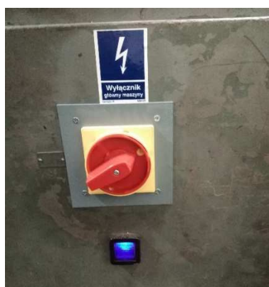
Rys. P12.3. Prawidłowy wyłącznik główny z odpowiednim znakiem informacyjnym
