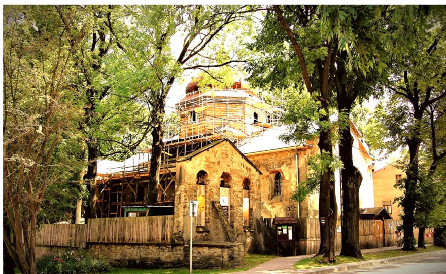
Ryc. 2. Cerkiew w Baligrodzie – p.w. Zaśnięcia NMP, murowana, wzniesiona w 1829 roku, w trakcie remontu od 2009 roku. Fot. Autorka
