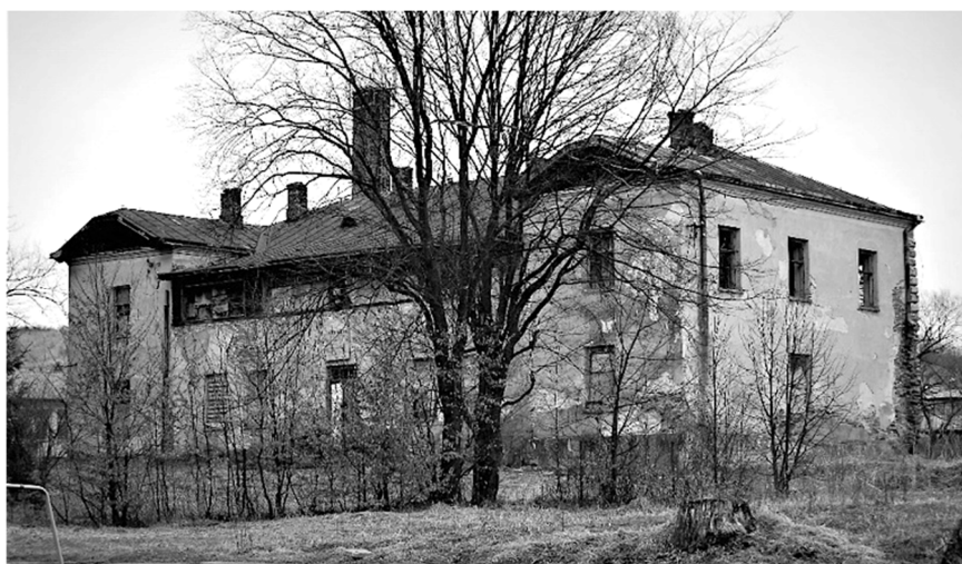
Ryc. 5. Uherce Mineralne – murowany dwór z alkierzami, częściowo przebudowany w 1830 roku, obecnie niezagospodarowany i popadający w ruinę. Fot. Autorka
