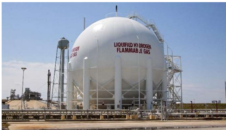
Rys. 7. Zbiornik ciekłego wodoru zainstalowany na platformie startowej NASA w Centrum Kosmicznym Kennedy'ego
