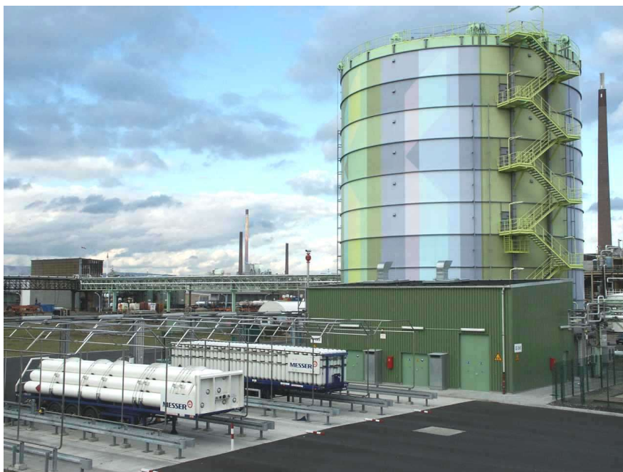
Rys. 4. Niskociśnieniowy zbiornik gazu Hydrogen Center Höchst 2006
