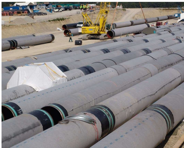
Rys. 6. Gazowy magazyn rurowy w Urdorf
