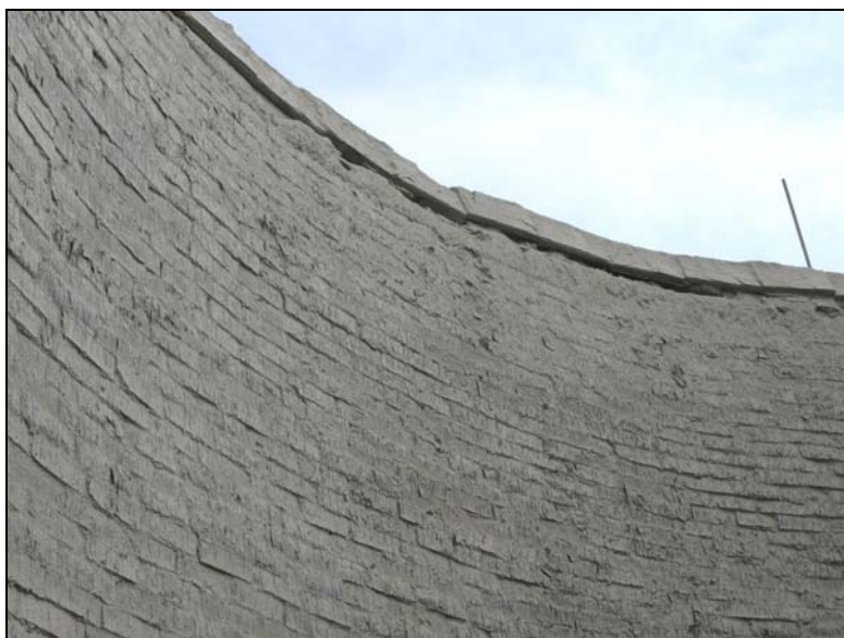
Fot. 1. Widok wewnętrznej powłoki komina
