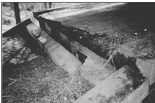
Rys. 3. Widok uszkodzonej podpory
