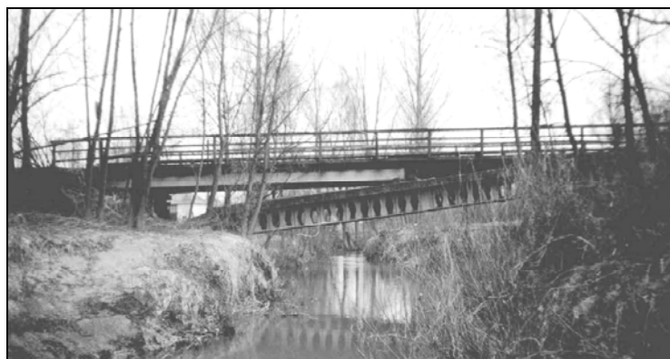
Rys. 1. Widok mostu z dołu rzeki
