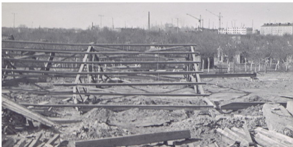
Rys. 11. Wiata po katastrofie spowodowanej działaniem wiatru (z prawej strony leżące słupy ściany szczytowej, wiązary dachowe w pozycji pionowej)
