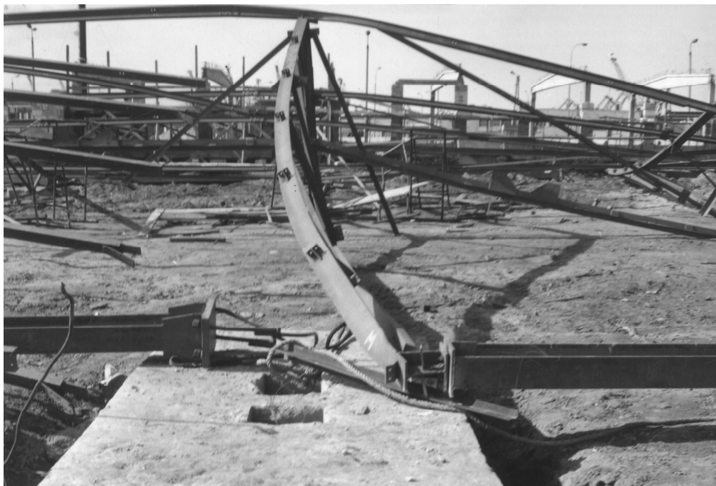
Rys. 12. Zdeformowana końcówka więzara nieoderwana od głowicy słupa
