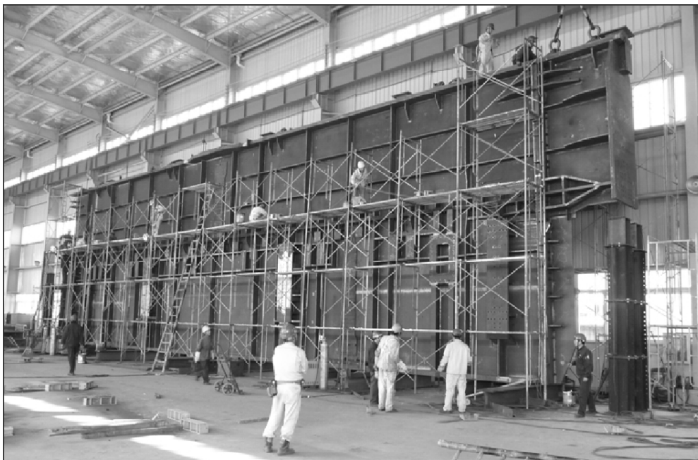
Rys. 13. Belka rusztu kotła w trakcie produkcji
