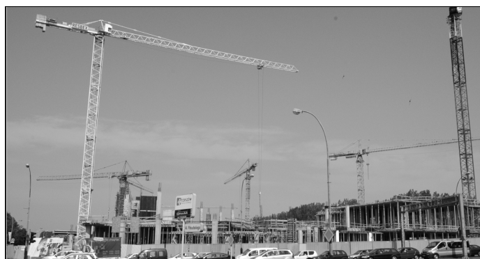
Rys. 3. „Galeria Rzeszów” w trakcie realizacji.
