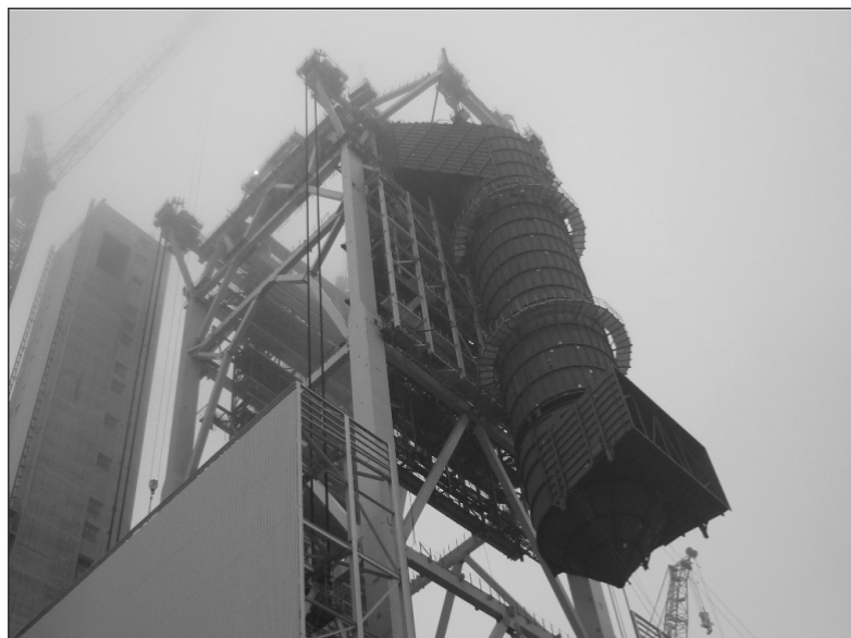
Rys. 17. Podnoszenie konstrukcji wiszącej (HBH) budynku kotłowni.
