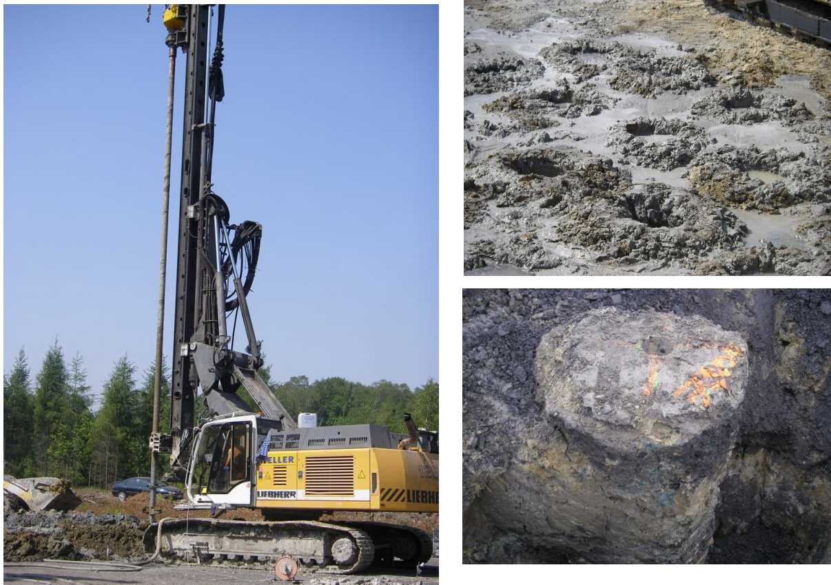
Rys. 3. Maszyna do głębokiego mieszania gruntu, wykonane „świeże” kolumny DSM i odkrywka kolumny DSM (Fot. własne)
