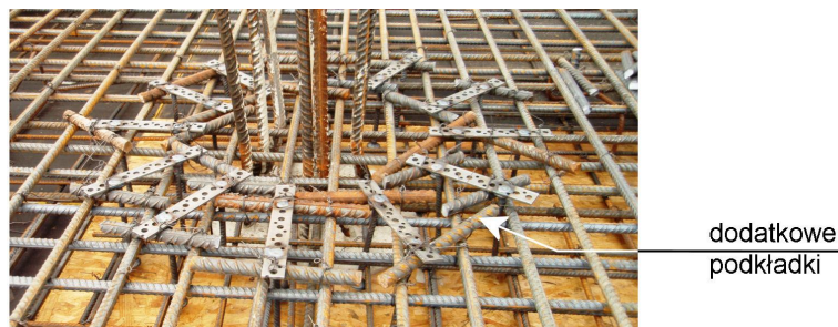
Rys. 1. Przykład obniżonego zbrojenia górnego o około 20 mm w strefie przysłupowej płaskiego stropu
