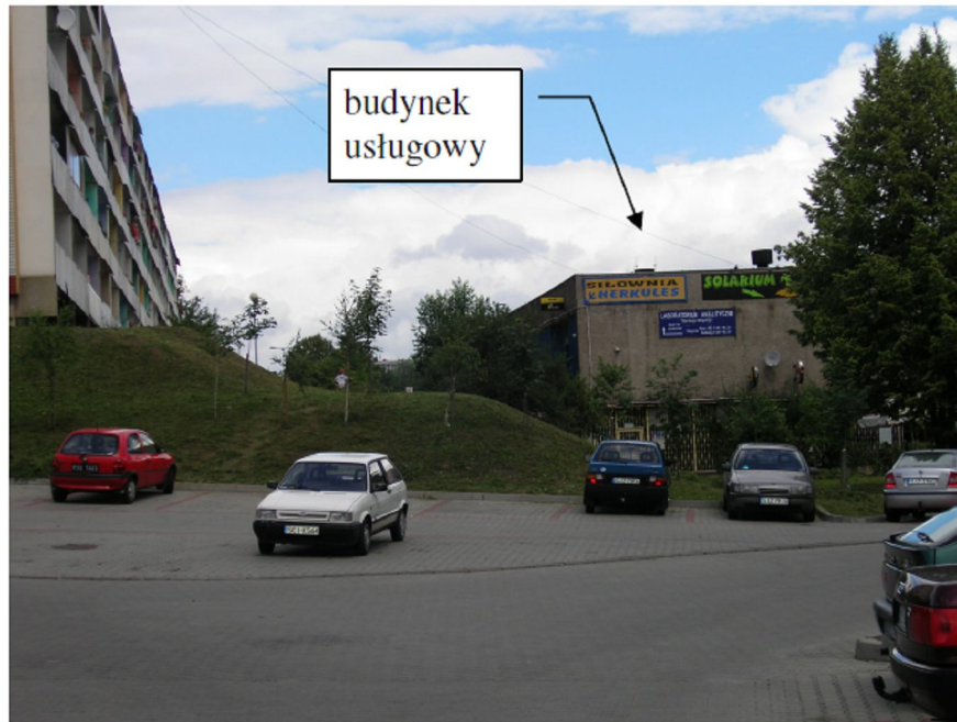
Rys. 1. Widok budynku usługowego i przyległej skarpy od strony zachodniej
