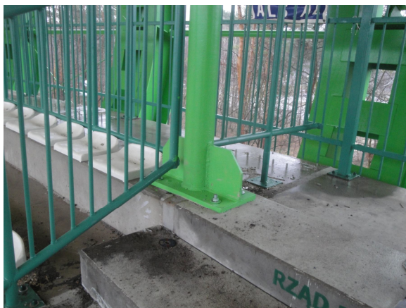
Rys. 14. Sposób podparcia słupa
