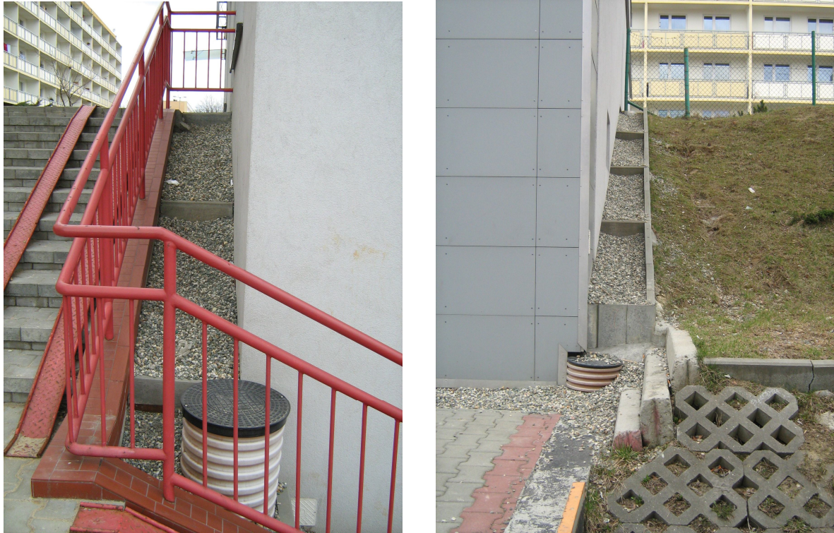
Rys. 8. Widok na budynek usługowy z wykonanym drenażem opaskowym
