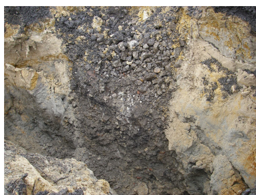
Rys. 2. Maszyna do wbijania kolumn kamiennych i odkrywki kolumn kamiennych (Fot. własne)
