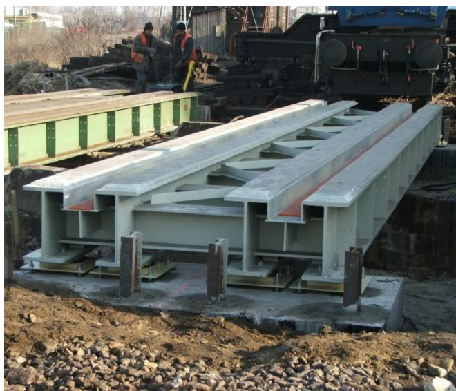
Fot. 1. Linia kolejowa nr 161 Katowice - Szopienice, km 1,075 – prefabrykowane przęsło mostu z nawierzchnią w systemie szyny w otulinie
