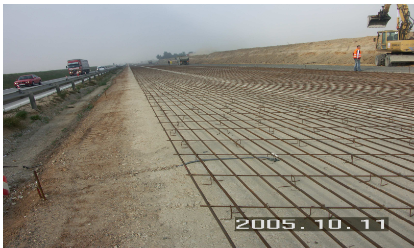
Fot. 11. Układ zbrojenia w nawierzchni
