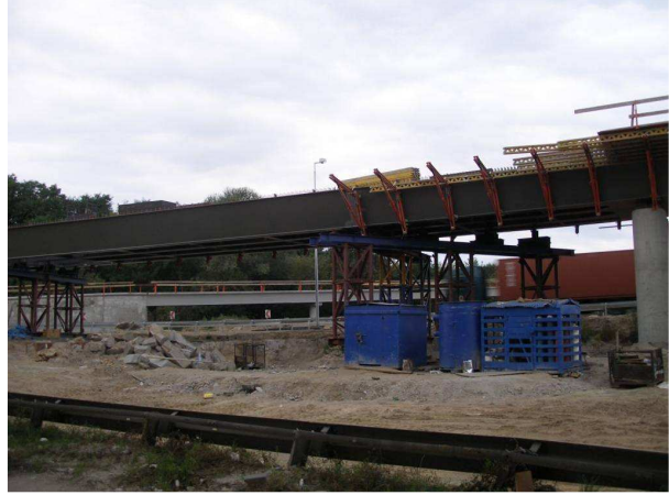
Rys. 5. Konstrukcja tymczasowo podparta
