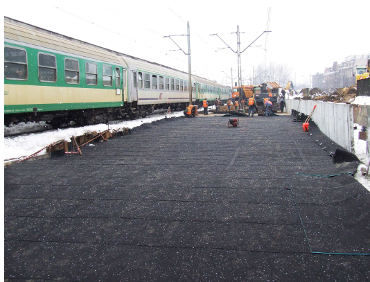
Fot. 13. Zastosowanie mat wibroizolacyjnych TRACKELAST w nawierzchni peronów Dworca Głównego w Katowicach
