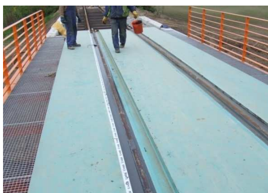
Fot. 11. Zastosowanie systemu szyny w otulinie ERS na obiektach inżynierskich
