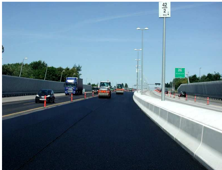
Rys. 6. Połączenie ścian redukujących hałas oraz unikalnej nawierzchni redukującej hałas firmy Skanska, SkanTOP XL Silence.
