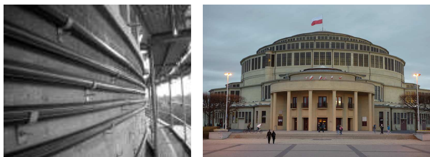
Rys. 21. Hala stulecia we Wrocławiu – zastosowane kable wzmacniające oraz widok hali po remoncie
