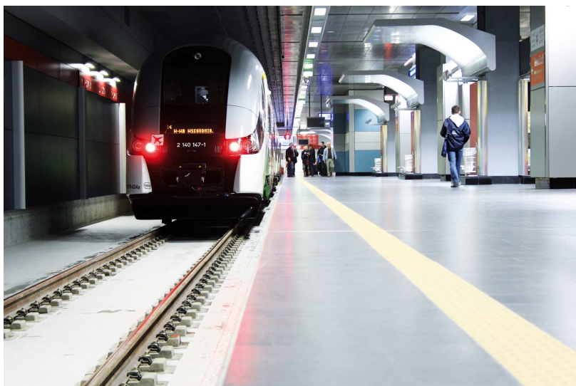
Fot. 6. Nawierzchnia bezpodsytkowa w systemie EBS na stacji kolejowej – Tunel na lotnisko Okęcie
