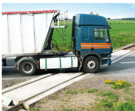
Fot. 12. Zastosowanie zintegrowanej nawierzchni kolejowo – drogowa LC-L
