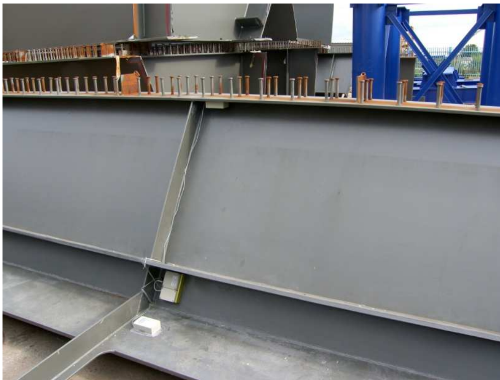
Rys. 3. Zainstalowane czujniki na konstrukcji w wytwórni
