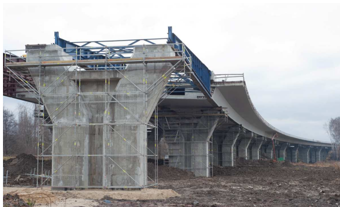
Rys. 14. Nasuwanie estakady E2+E3
