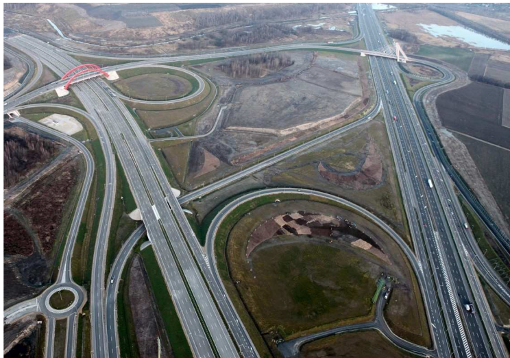
Rys. 1. Węzeł Sośnica – przecięcie A1 z A4 [1].
