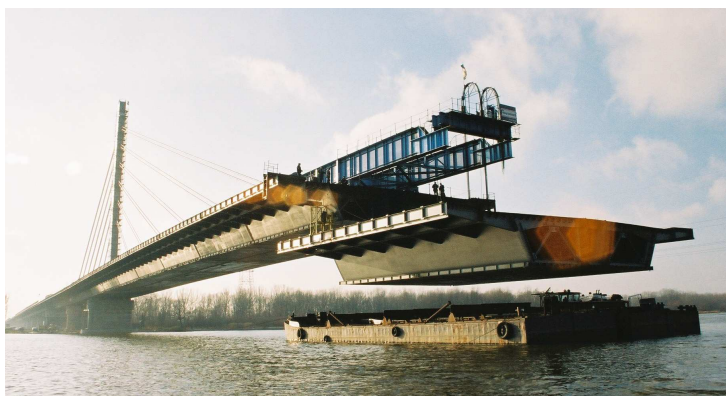
Rys. 8. Most podwieszony przez Wisłę w Płocku – podnoszenie kolejnego segmentu
