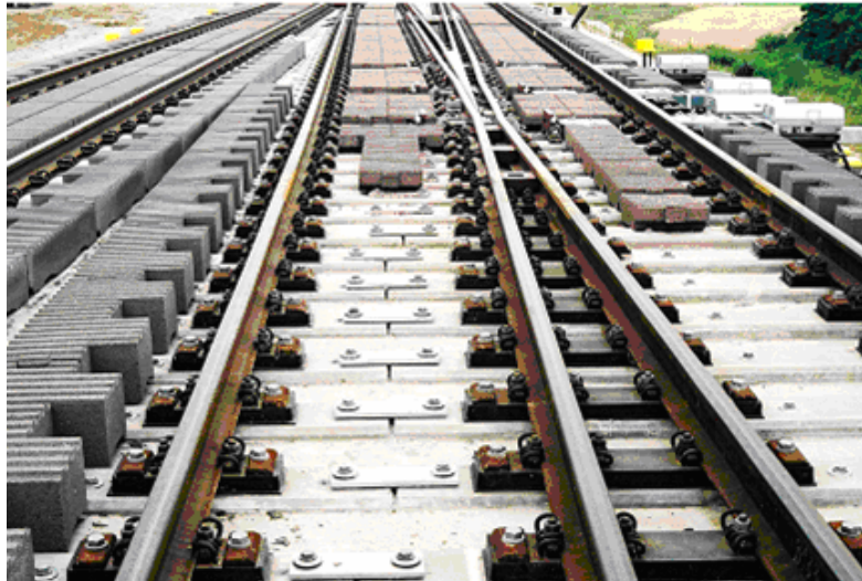
Rys. 5. Rozjazd mający krzyżownicę z ruchomym dziobem i urządzeniami tłumiącymi hałas ułożony na płycie typu Rheda (fot firma Rheda)
