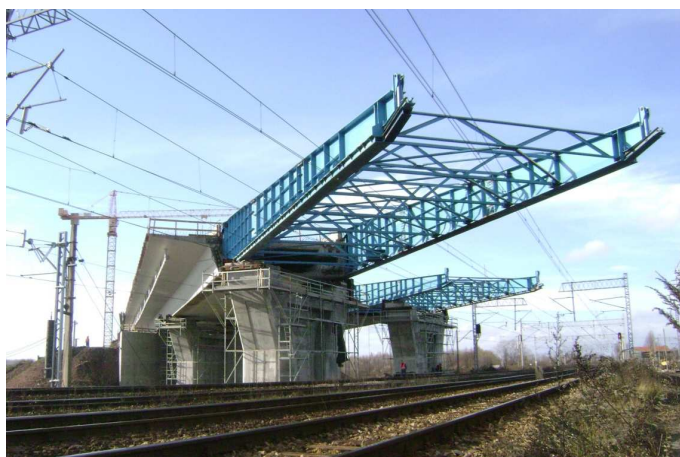
Rys. 15. Nasuwanie estakady E4 nad torami kolejowymi
