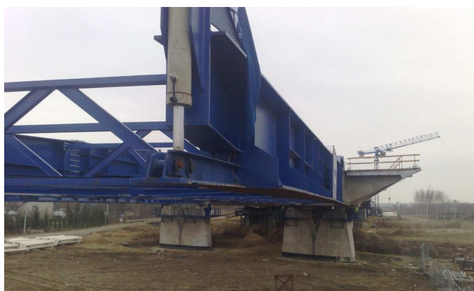
Rys. 16. Most MA-161 - widok blachownicy dziobu montażowego przed dotarciem do kolejnej podpory
