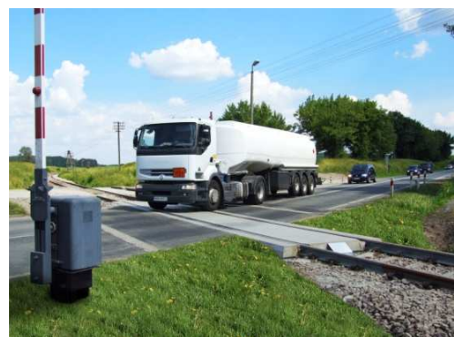
Fot. 12. Zastosowanie zintegrowanej nawierzchni kolejowo – drogowa LC-L
