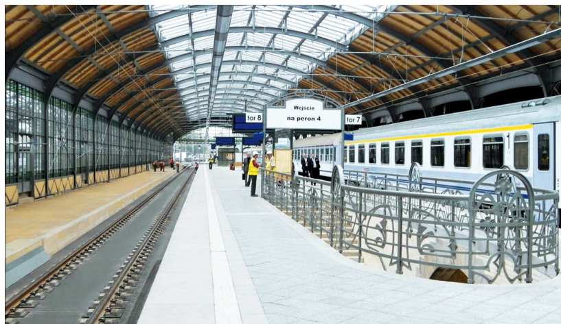
Fot. 8. Zastosowanie nawierzchni bezpodсыpkowej w systemie EBS w modernizacji Dworca Wrocław Główny
