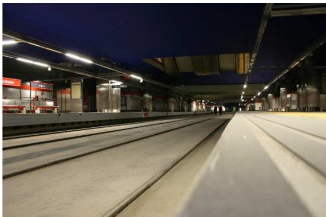
Fot. 3. Stacja podziemna kolejowa w Madrycie z bezpodsypkową konstrukcją nawierzchni według systemu szyny w otulinie.
