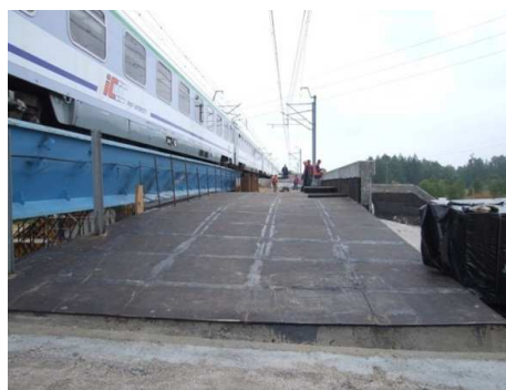
Fot. 14. Zastosowanie mat wibroizolacyjnych TRACKELAST w nawierzchni Dworca Kraków Główny oraz Centralnej Magistrali Kolejowej
