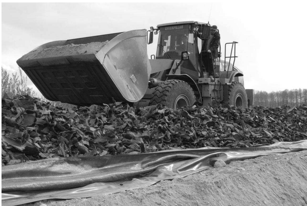
Rys. 4. Wykończenie nasypu drogowego. Układanie warstwy strzępów gumowych jako jednej z warstw konstrukcyjnych nasypu. Czuprynowo, rok 2011. Źródło: Mostostal Warszawa S.A.
