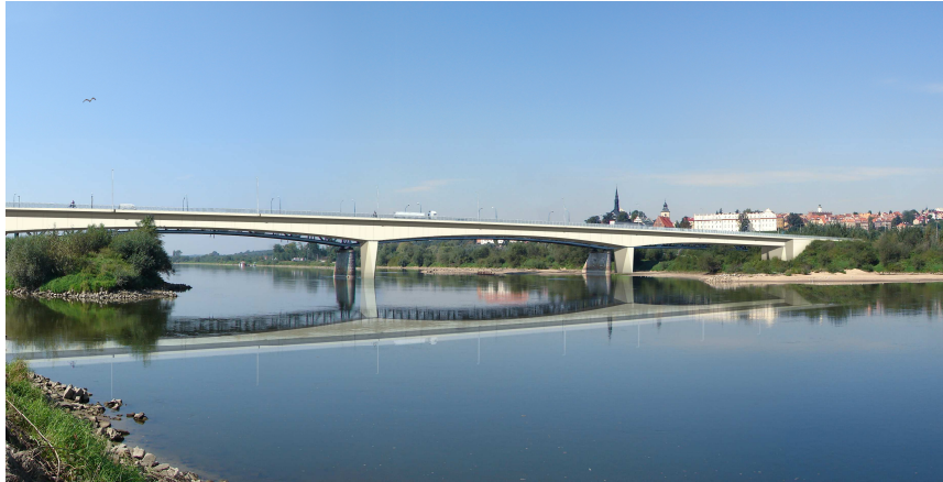
Rys. 6. Nowy most przez Wisłę w Sandomierzu, 85,80 + 3 x 95.40 + 84,80 m, 2011 rok
