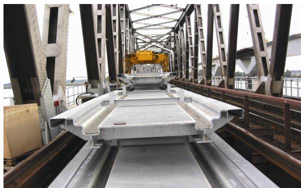
Fot. 5. Przykład modułowej konstrukcji nawierzchni w systemie ERS na obiekcie inżynierskim - Holandia
