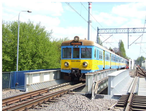
Fot. 11. Zastosowanie systemu szyny w otulinie ERS na obiektach inżynierskich
