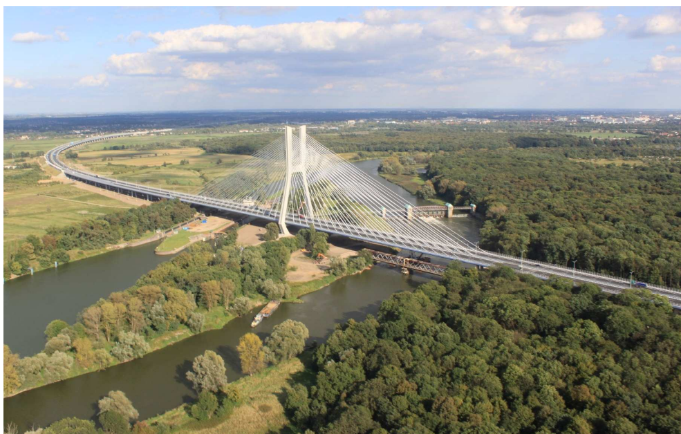
Rys. 3. Widok mostu Rędziańskiego we Wrocławiu
