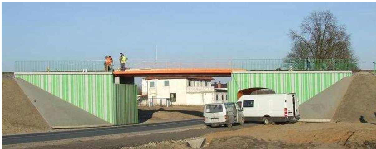
Fot. 4. Obiekt inżynierski z nawierzchnią wykonaną w systemie szyny w otulinie ERS – Szydłowo, linia nr 403
