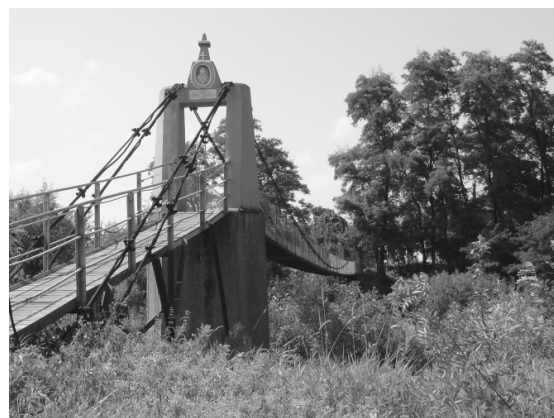
Rys. 2. Wygląd kładki w Krzyżanowicach (zdj. Aut. Lipiec 2009)
