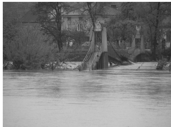
Rys 9. Kładka w Krzyżanowicach w czasie powodzi (fot. portal bochnianin.pl)
