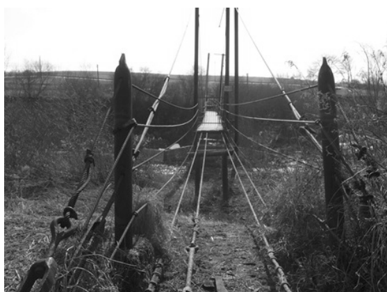
Rys. 10. Zniszczona kładka między Gliniczkiem i Jasłem (zdj. portal jaslonet.pl)
