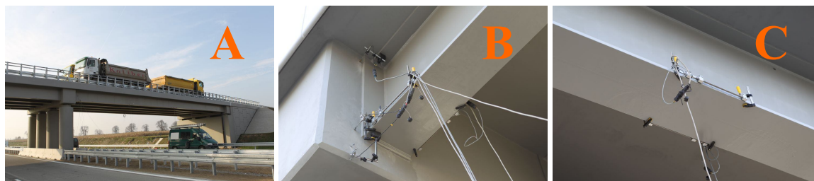
Rys.6. Weryfikacyjne próbne obciążenie: A - statyczne ustawienie przęsłowe U1, B - czujniki w strefie podporowej uszkodzonego dźwigara, C - czujniki pomiarowe w miejscu uderzenia na pasie dolnym dźwigara
