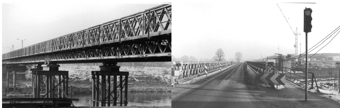
Rys. 1. Konstrukcja MS-54 wykorzystana do budowy mostu na Odrze (dł. 140 m) w ciągu drogi krajowej nr 936 w Krzyżanowicach, po powodzi w 1997 r. (widoczne ograniczenie szerokości jezdni)
