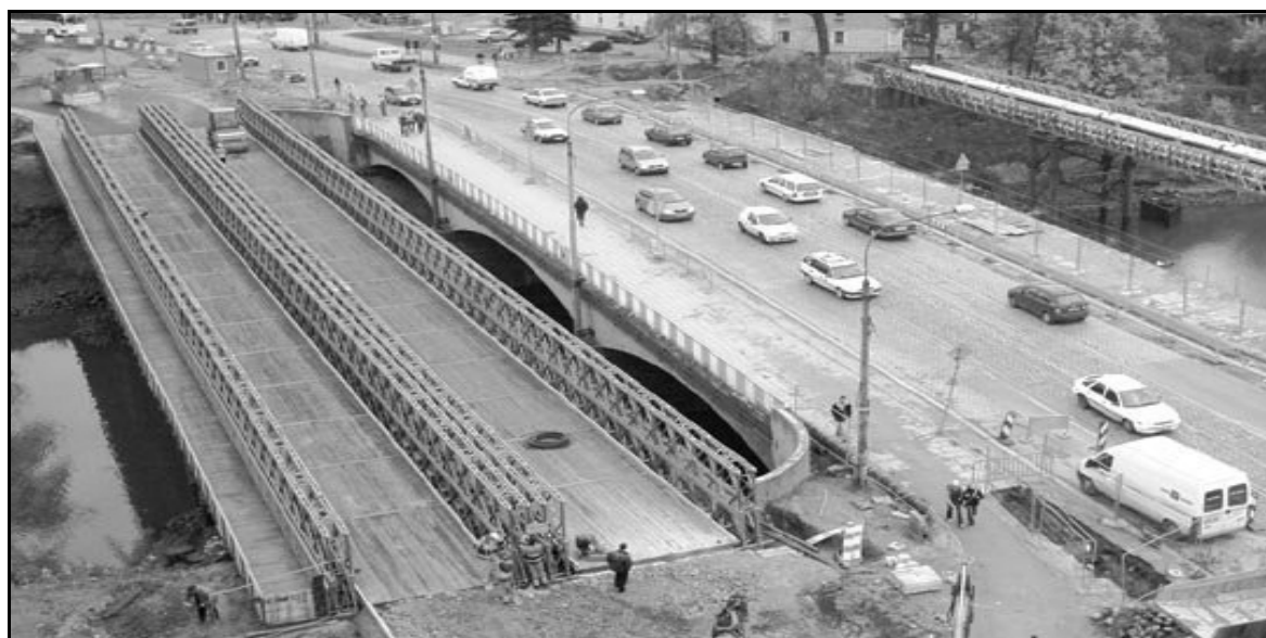
Rys. 4. Budowa mostu objazdowego z konstrukcji MS 22-80, z prawej strony widoczny most technologiczny (fot. Marcin Obara/ AG [10])
