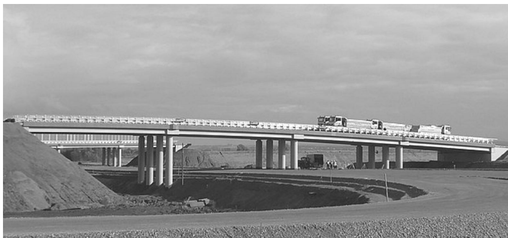
Rys 1. Typowy obiekt nad autostradą podczas badań pod próbnym obciążeniem
