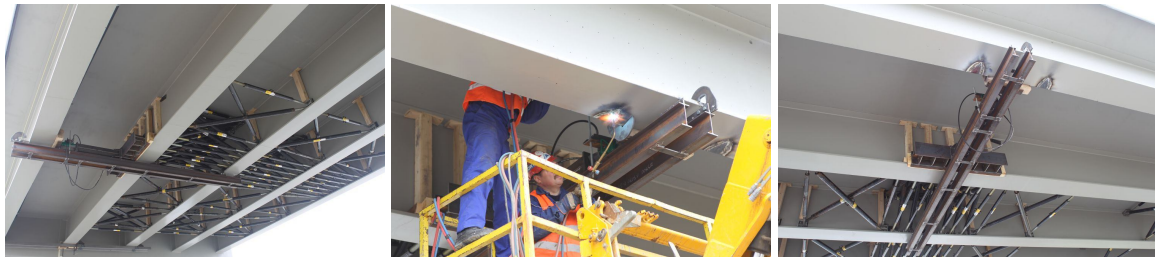
Rys.5. Konstrukcja wzmacniająca i wsporcza do prostowania dźwigara, fazy przywracania pierwotnej geometrii
