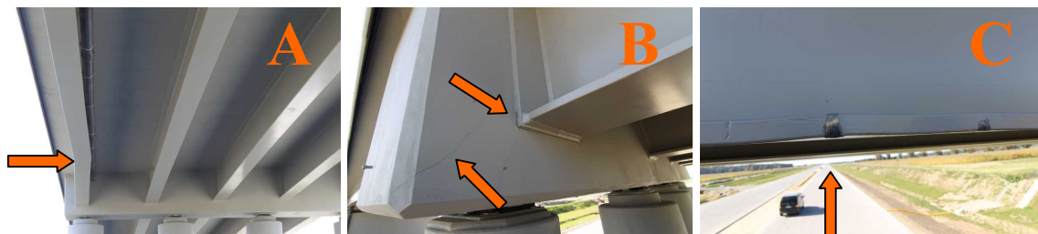
Rys.2. Uszkodzenia skrajnego dźwigara głównego: A - trwałe poziome przemieszczenie pasa ze skruceniem i środkiem z wygięciem, B - odspojenie blachy czołowej dźwigara i zarysowanie poprzecznicy nad filarem, C - lokalna, trwała deformacja krawędzi pasa w miejscu uderzenia
