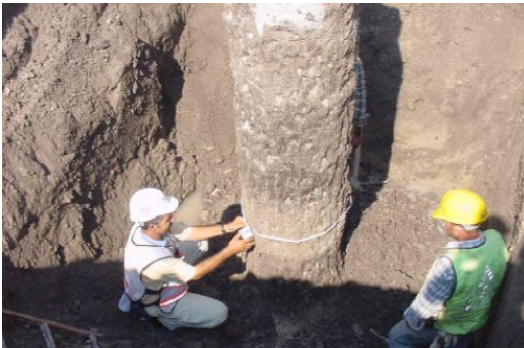
Rys. 4 Pomiar średnicy kolumny iniekcyjnej odsłoniętej do głębokości 3,5 m [5]
