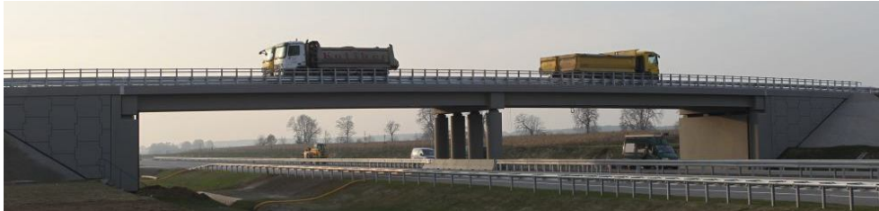
Rys.1. Widok ogólny wiaduktu (próbne obciążenie po naprawie)
