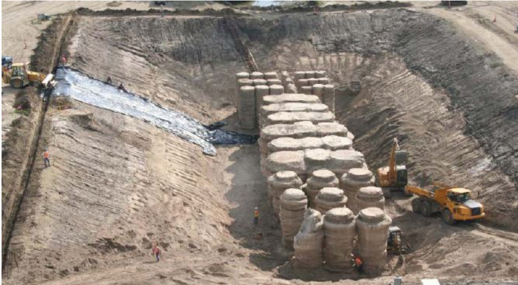
Rys. 3. Odslonięcie kolumn iniekcyjnych [4]
