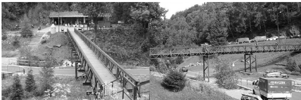
Rys. 3. Kładka dla pieszych, z konstrukcji MS 22-80, nad drogą w miejscowości Walim (Rzeczka) [5]
